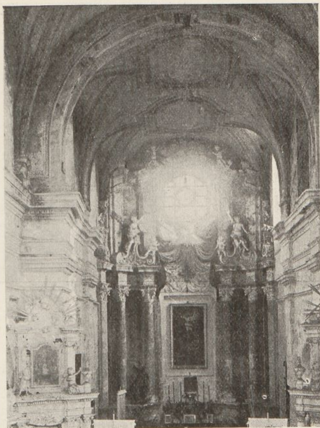
F. 77b. Kościół po-Dominikański w Stolpcach, z. nowogr., z r. 1640, fundacji Słuszków. Sklepienie typu lubelskiego. Por. f. 80, 81.
