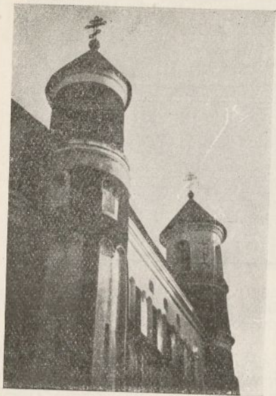
F. 57. Małomożejków, pow. lidzki, por. f. 58. długie wnęki z dwunależ- czem w cylindrycznych flankujących wieżycz- kach świątyni. Fot. J. Romer.
