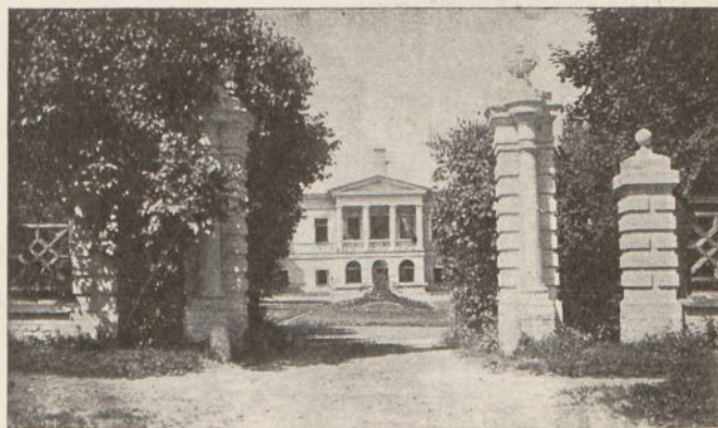
F. 93. Architekt K. Podczaszyński (1824—28). Pałac M. Bałińskiego w Jaszunach pow. wil. Fot. Z. Potapowicz.
