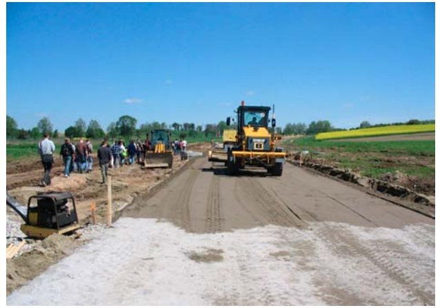
Fot. 4. Nowoczesne urządzenia do budowy dróg
