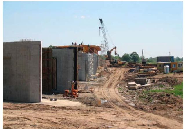
Fot. 5. Podpory środkowe betonowego obiektu mostowego
