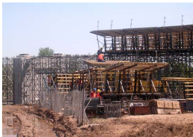
Fot. 6. Szeroki zakres prac mostowych realizowanych wiosną 2005 roku
