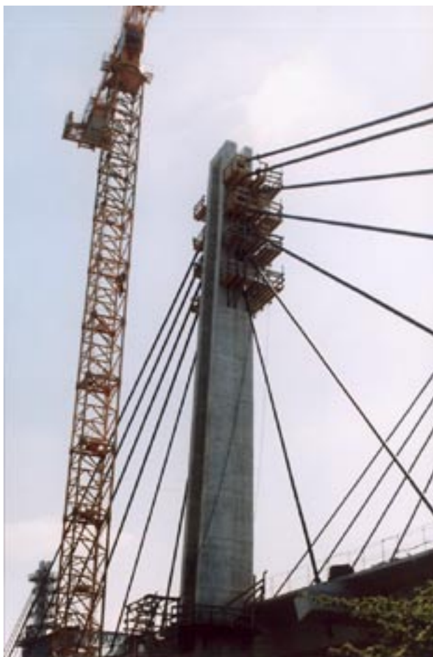
Widok na budowany most Milenijny. Słup pylonu od strony dolnej wody
