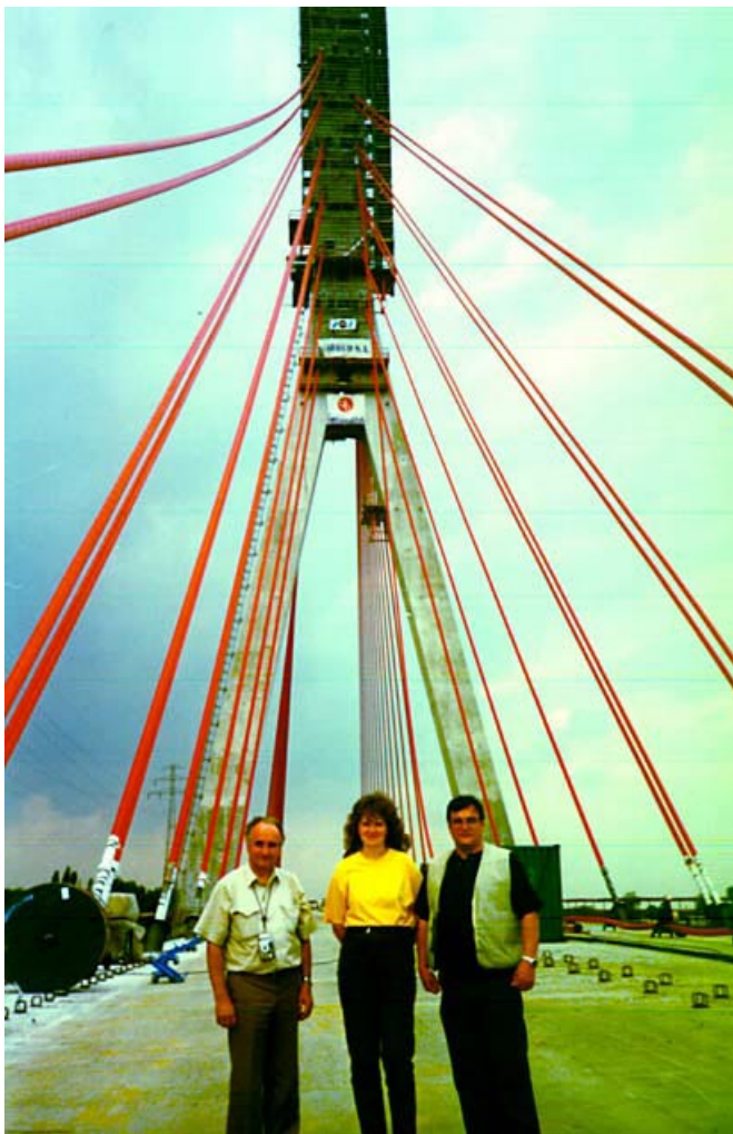
Zespół Konstrukcji Metalowych na podwieszonym, jedno-pylonowym moście Sucharskiego w Gdańsku, wykonywanym metodą nawisową bez użycia podpór tymczasowych
