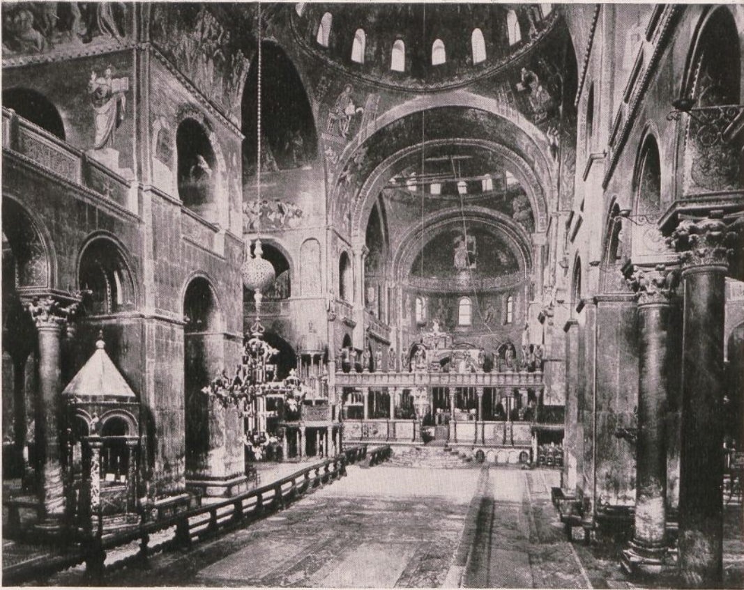
Abb. 62. Der Vierungsaufbau in der Markuskirche zu Venedig.
