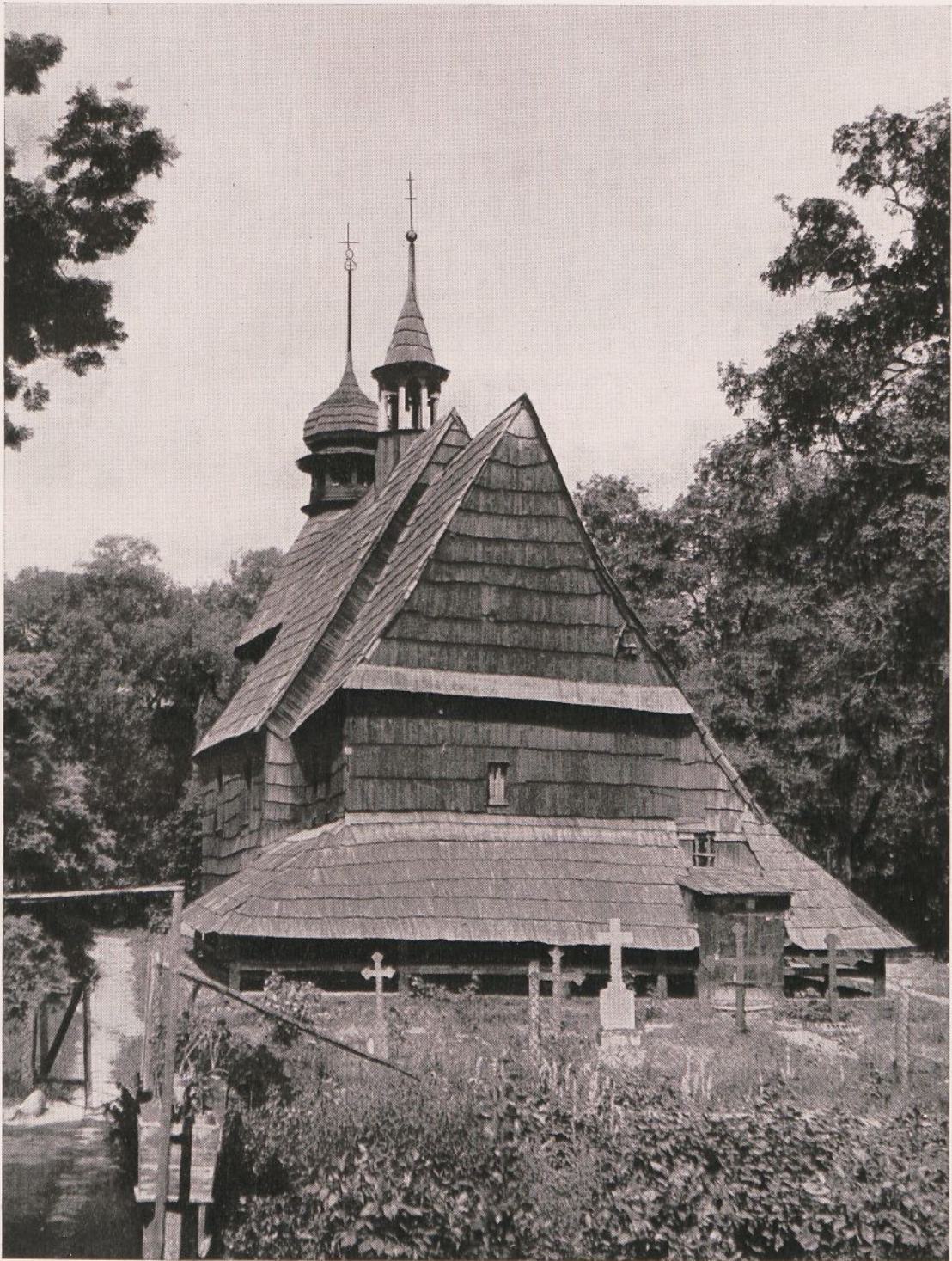
Abb. 24. Die Schrotholzkirche zu Pniow in Oberschlesien. Der Mittelteil mit dem Dachreiter erhebt sich über dem Quadrat; ganz hinten der Turm.
