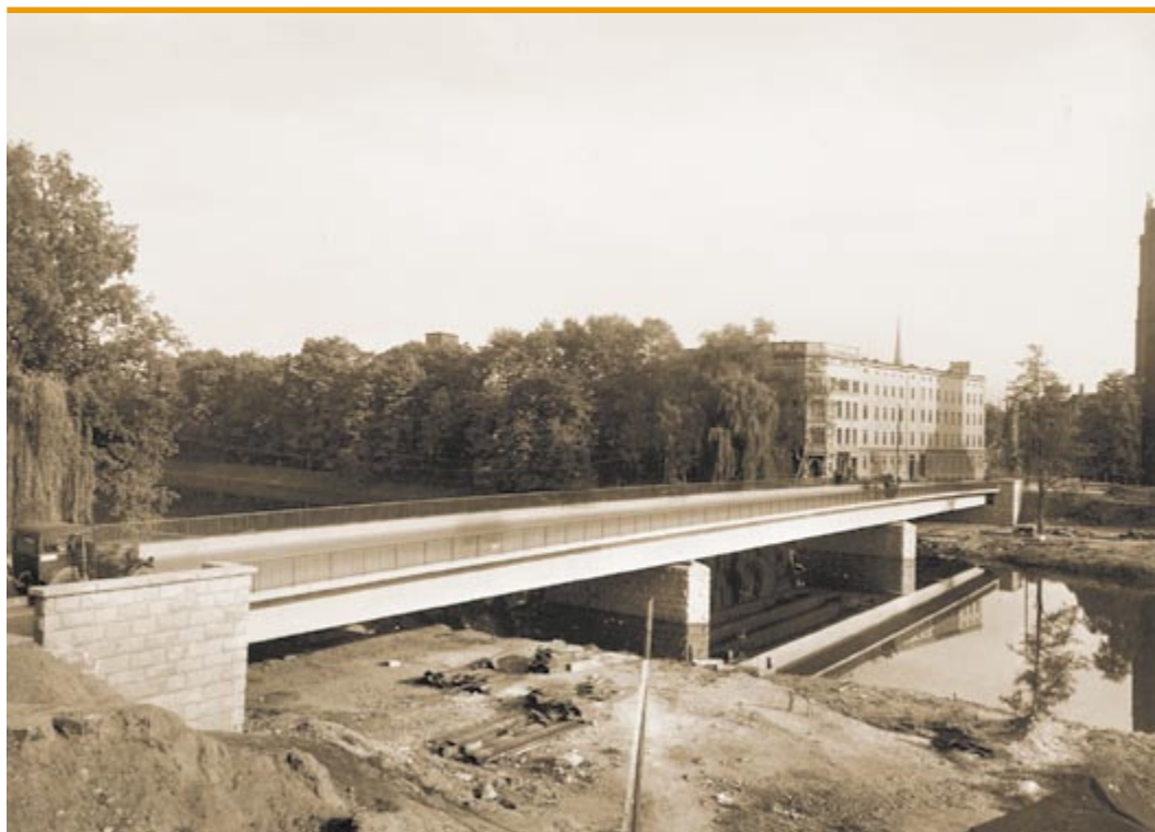
Most berliński (Pionierbrücke) na Nysie Kłodzkiej, Nysa, 1939 r.
