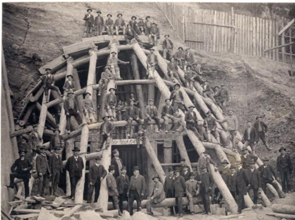
Budowniczości Feuerbach Tunnel w Wirtembergii, maj 1910 r.
