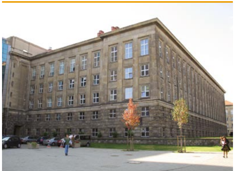
Widok budynku od północnego wschodu
