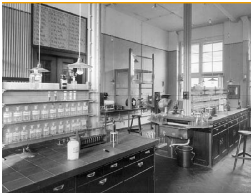
Pracownia w skrzydle zachodnim; fot. Anton Pichler, 1910 r.
