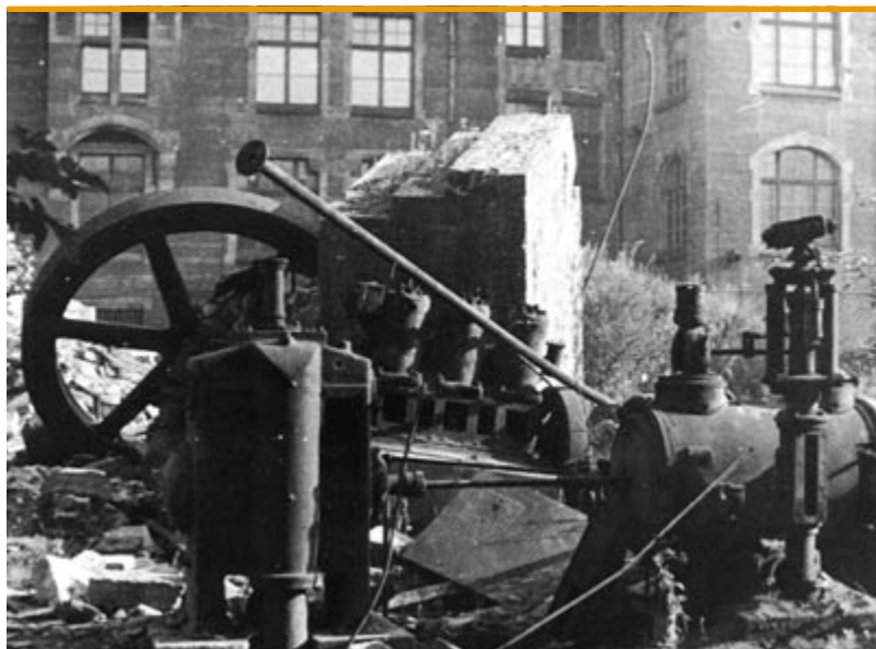
Ruiny hali maszyn dawnego laboratorium maszynowego, ok. 1945 r. Fot. A. Jellonek
