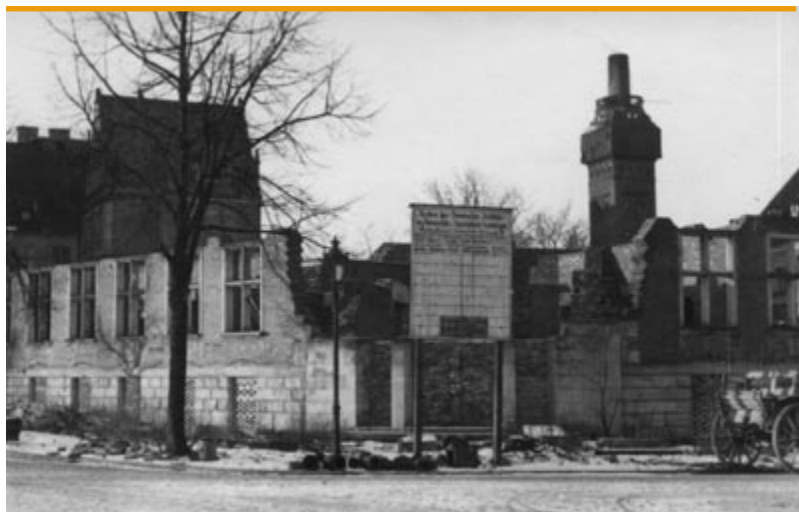
Pozostałości rozpoczętej budowy; fot. Andrzej Jellonek, 1945 r. (własność: Krzysztof Jellonek)
