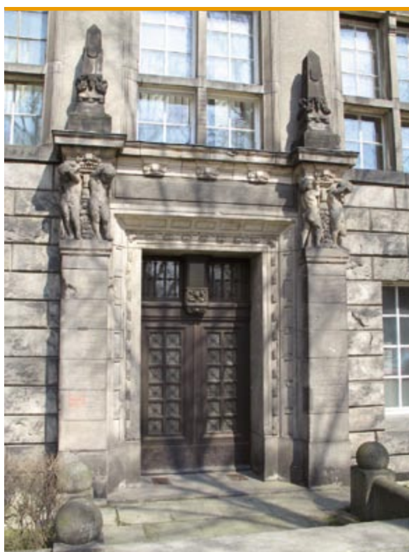
Portal elewacji południowej
