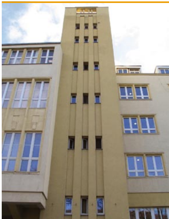
Środkowa część fasady – pion klatki schodowej
