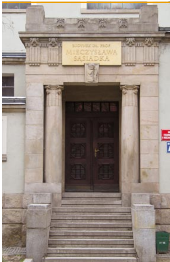
Portal wejścia głównego
