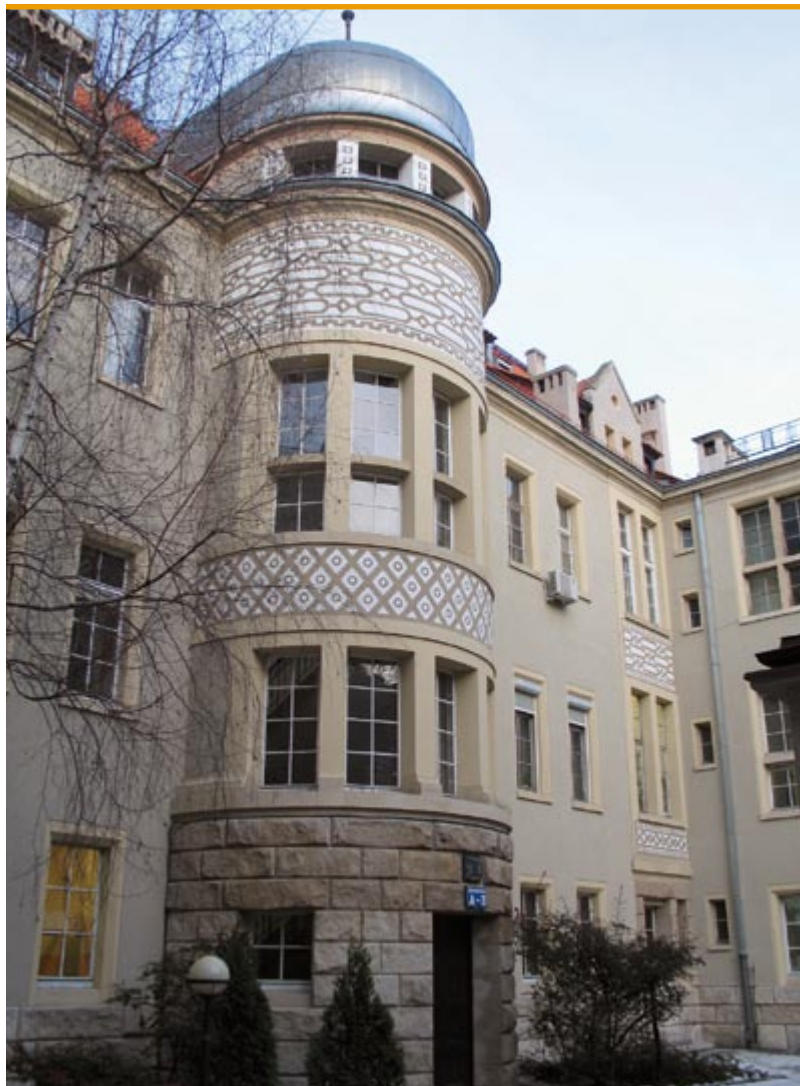
Fragment elewacji południowej z ryzalitem głównej klatki schodowej
