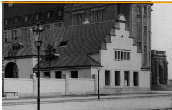
Obiekt w stanie surowym; fot. Eduard van Delden, Heinrich Götz, ok. 1910 r.
