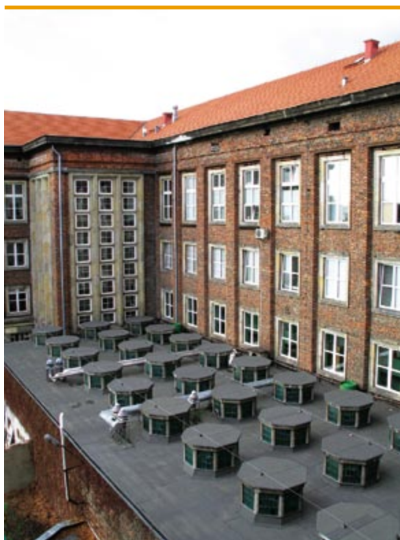
Fragment elewacji dziedzińcowej
