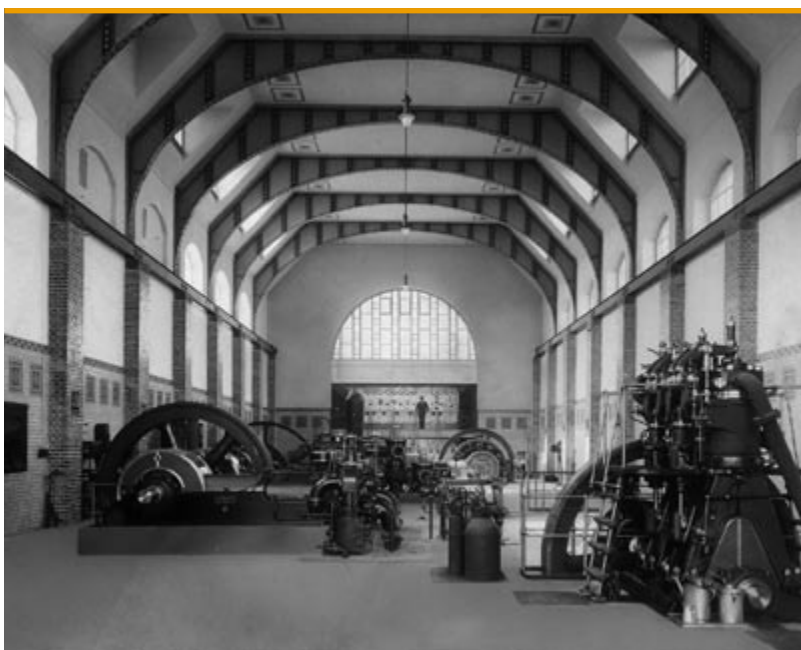
Hala maszyn – widok w kierunku południowym; fot. Eduard van Delden, Heinrich Götz, ok. 1910 r.
