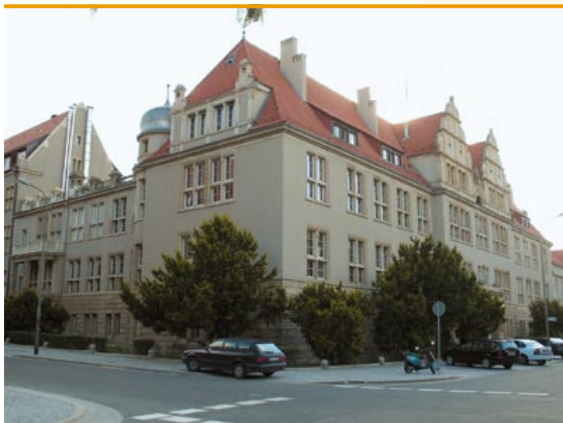
Budynek dawnego Instytutu Chemicznego – widok od północnego wschodu
