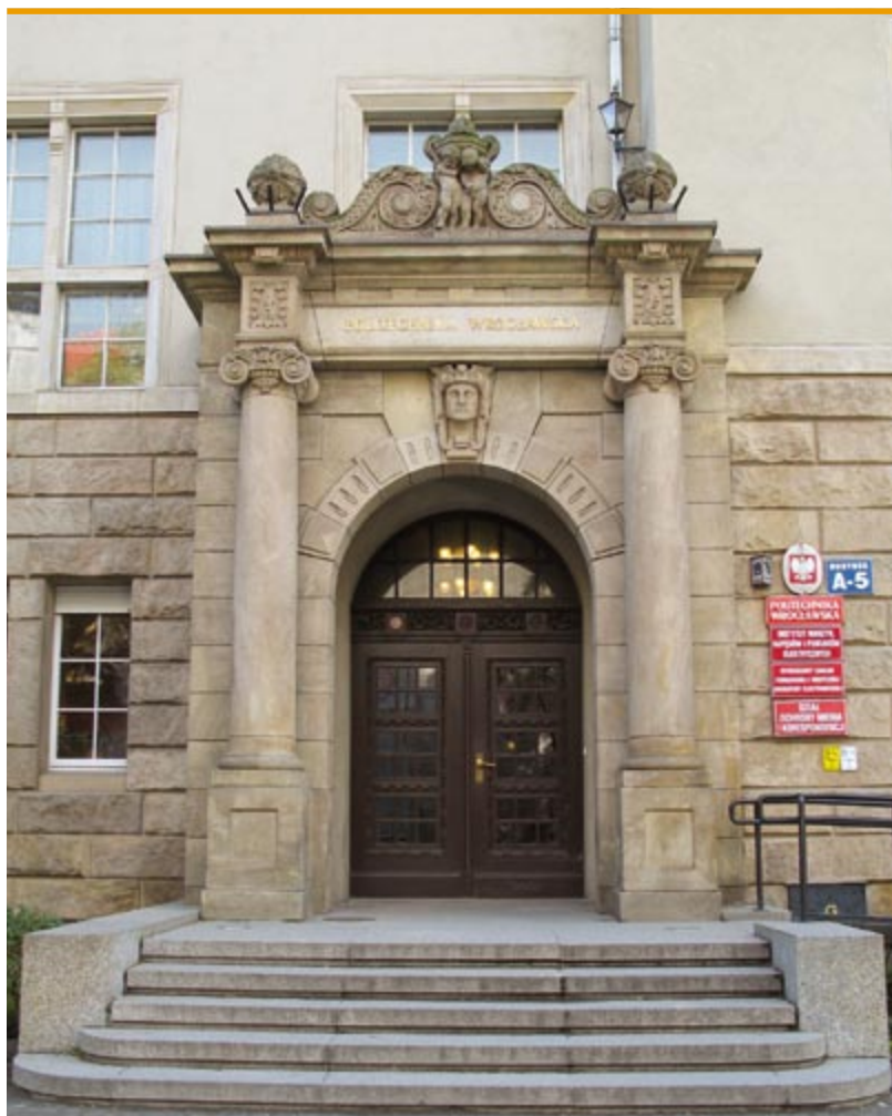
Portal wejścia głównego
