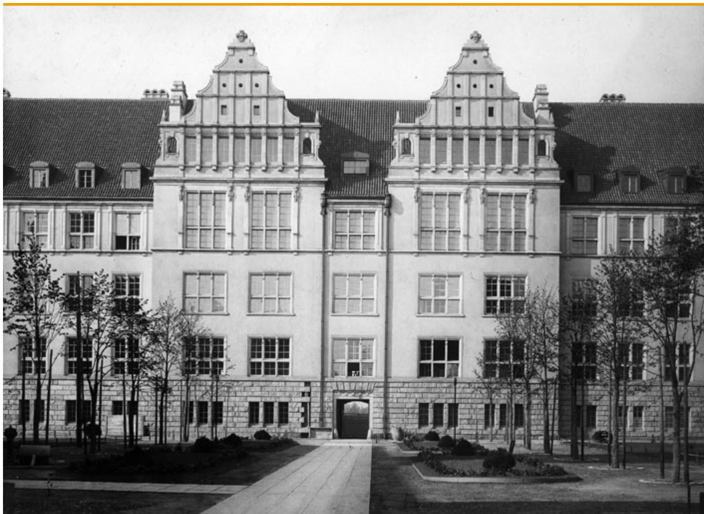
Elewacja północna; fot. Eduard van Delden, Heinrich Götz, ok. 1910 r.
