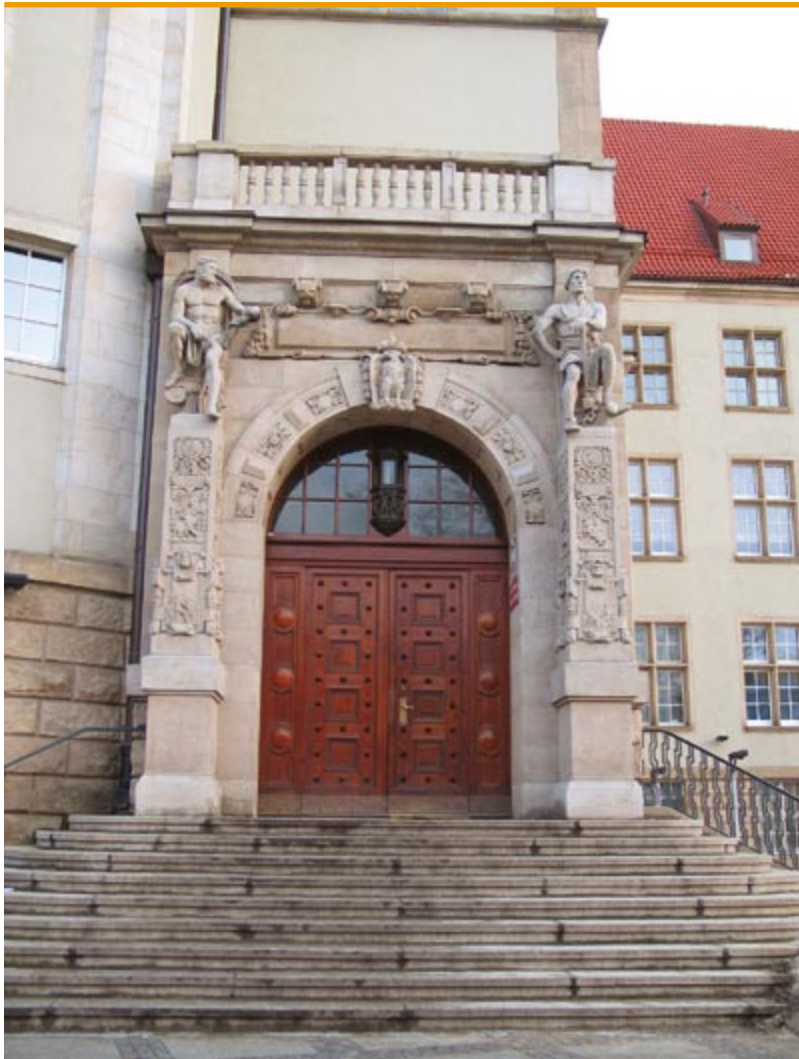
Dawne główne wejście uczelni, tzw. portal cesarski; stan z 2009 r.
