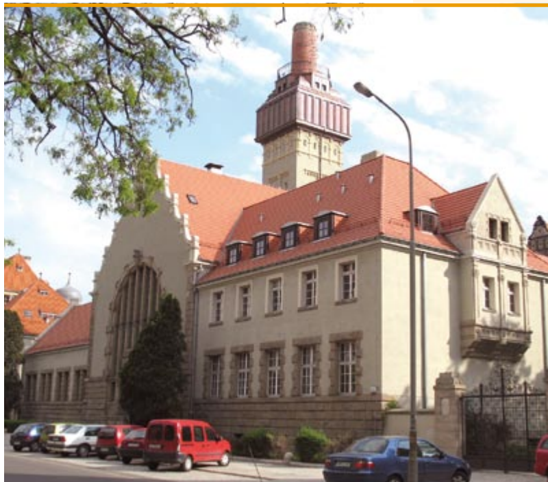
Budynek dawnego Laboratorium Maszyn – widok od północnego zachodu
