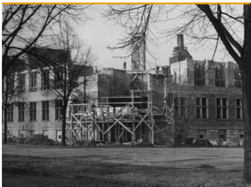
Budowa nowego gmachu Instytutu Chemicznego; fot. Bronisław Kupiec, ok. 1950 r.
