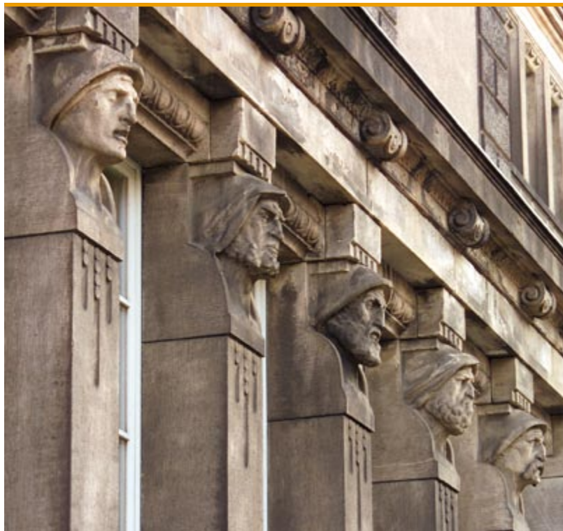
Dekoracja rzeźbiarska północnego odcinka elewacji zachodniej
