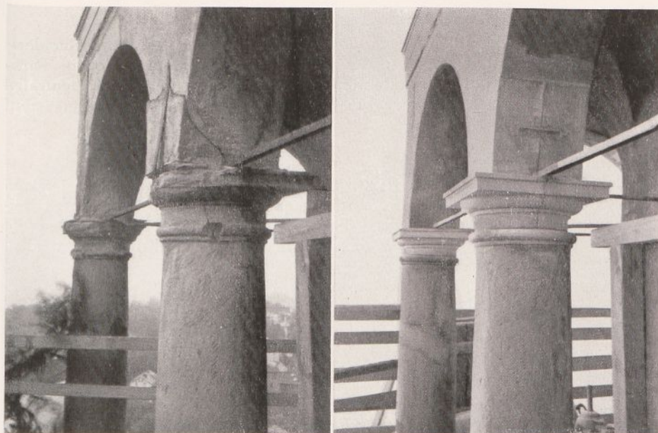
76 u. 77. Glatz. Rathausturm. Säulen am Oberbau vor und nach der Instandsetzung
