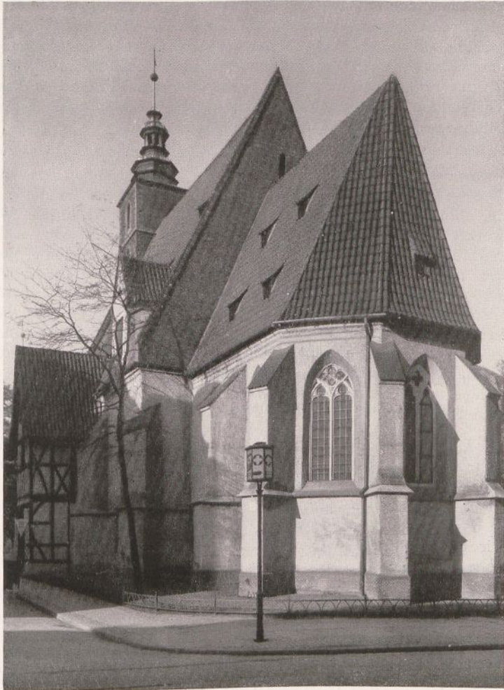
62. Breslau. Christophori- kirche nach der Instandsetzung
