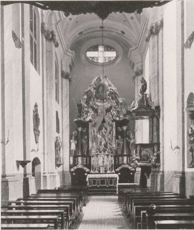
73. Ursulinerinnenkloster. Inneres der Außenkirche nach der Instandsetzung
