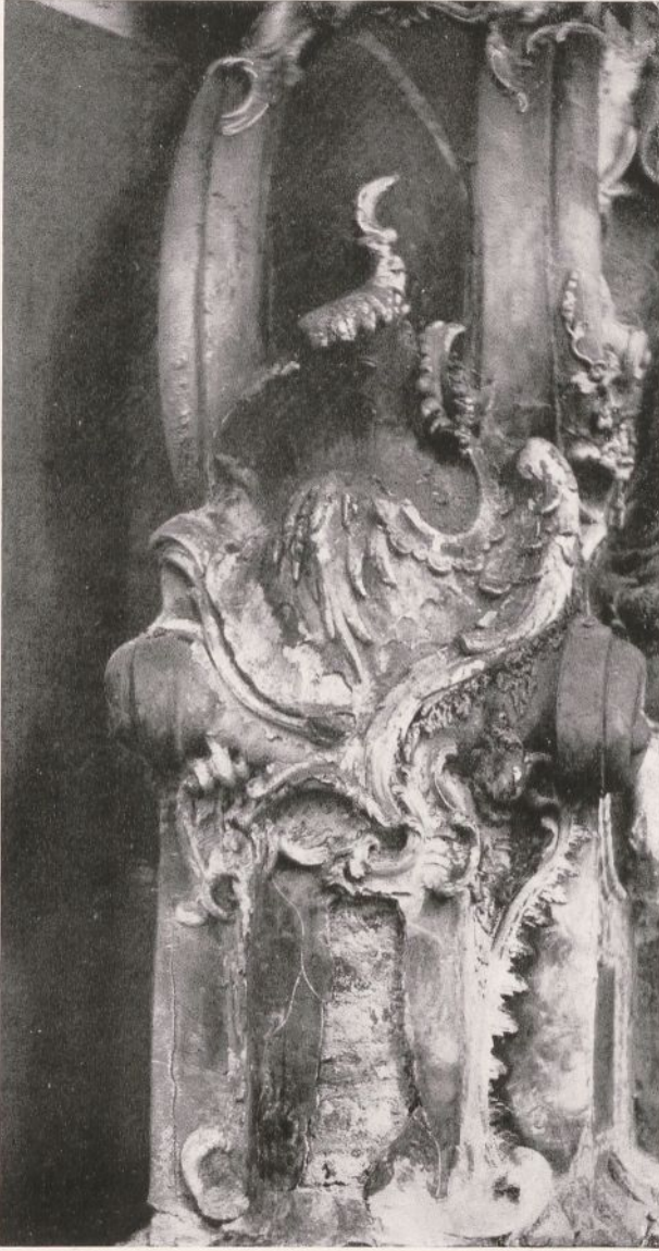
70. Breslau, Dorotheen- kirche. Detail vom Grabmal Spaetgen vor der Instandsetzung
