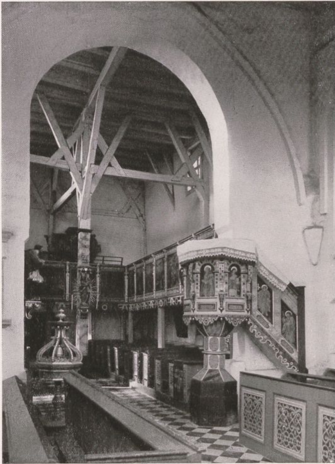
16. Groß Bresa, Blick in das Langhaus
