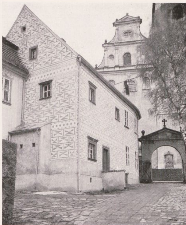
107. Schömberg. Küsterhaus der kath. Kirche mit instandgesetztem Sgraffitoputz
