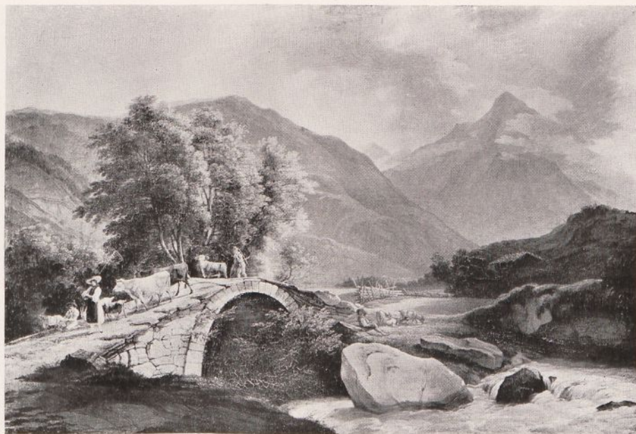
135. Adolf Kunkler, Brücke über den Reichenbach. 1826
