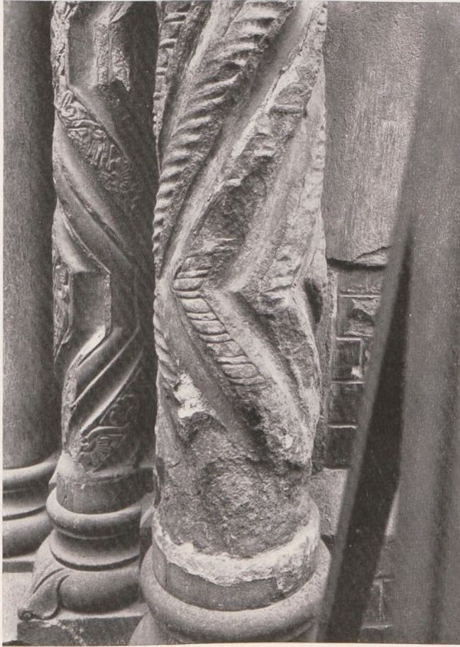
72. Breslau. Magdalenenkirche. Detail vom roma- nischen Portal vor der Instandsetzung
