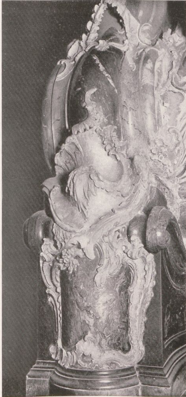
71. Breslau. Dorotheen- kirche. Detail vom Grabmal Spaetgen nach der Instandsetzung
