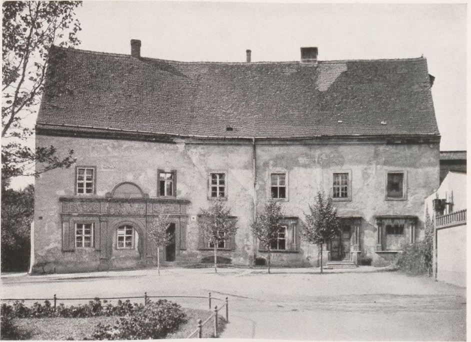
98. Haynau. Piastenschloß vor der Instandsetzung
