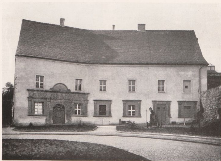
99. Haynau, Piastenschloß nach der Instandsetzung Die Türöffnung ist an die ursprüngliche Stelle verlegt
