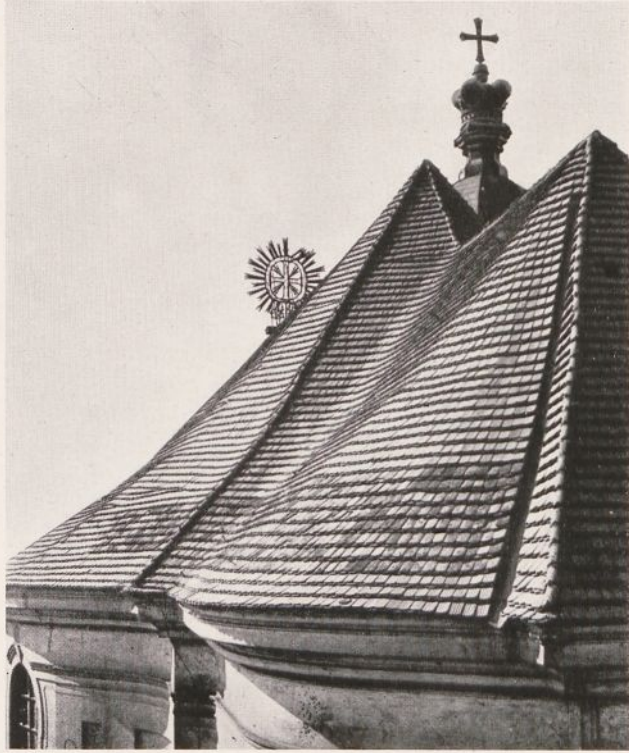
109. Wahlstatt. Dach der Klosterkirche vor der Instandsetzung
