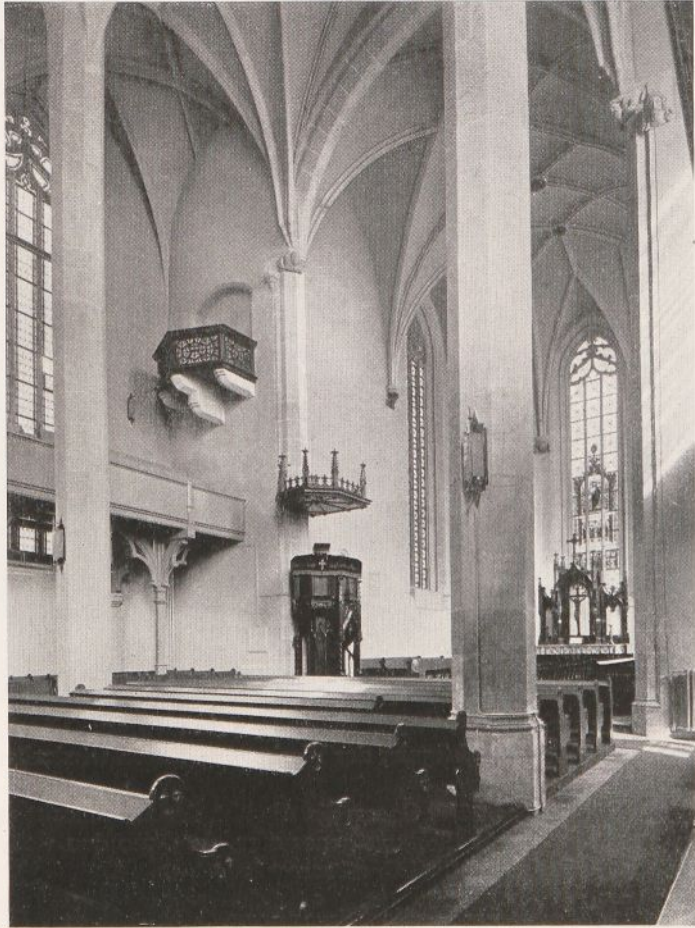
95. Görlitz. Ev. Frauenkirche. Inneres nach der Instandsetzung
