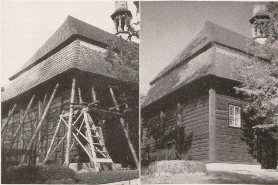
78 u. 79. Groß Wartenberg. Kath. Kirche während und nach der Instandsetzung
