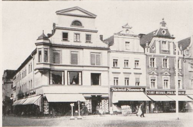
92 u. 93. Bunzlau. Bürgerhaus am Ring vor und nach der Instandsetzung
