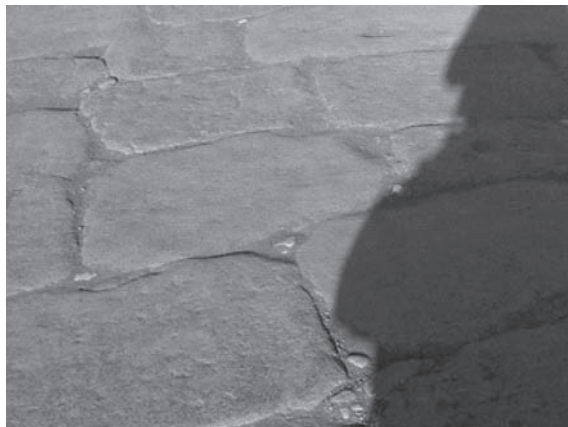
Fot. 1. Bruk ulicy w Pompejach wykonany z płyt bazaltowych, uzupełnianych inkluzjami z marmuru, fot. S. Wróblewski 2015
