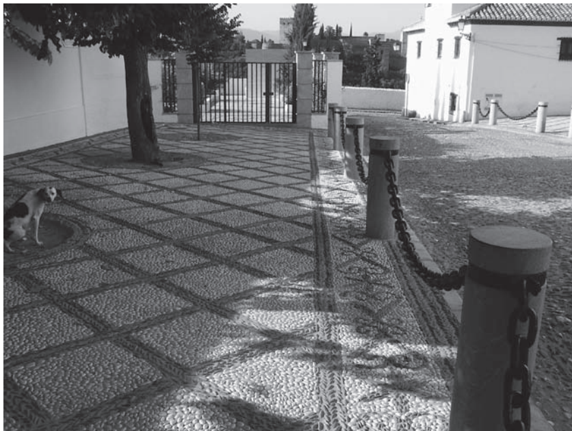
Fot. 9. Posadzka otoczkowa na chodnikach w Granadzie, o kompozycji z XIX wieku, poddana renowacji. Fot. S. Wróblewski 2007
