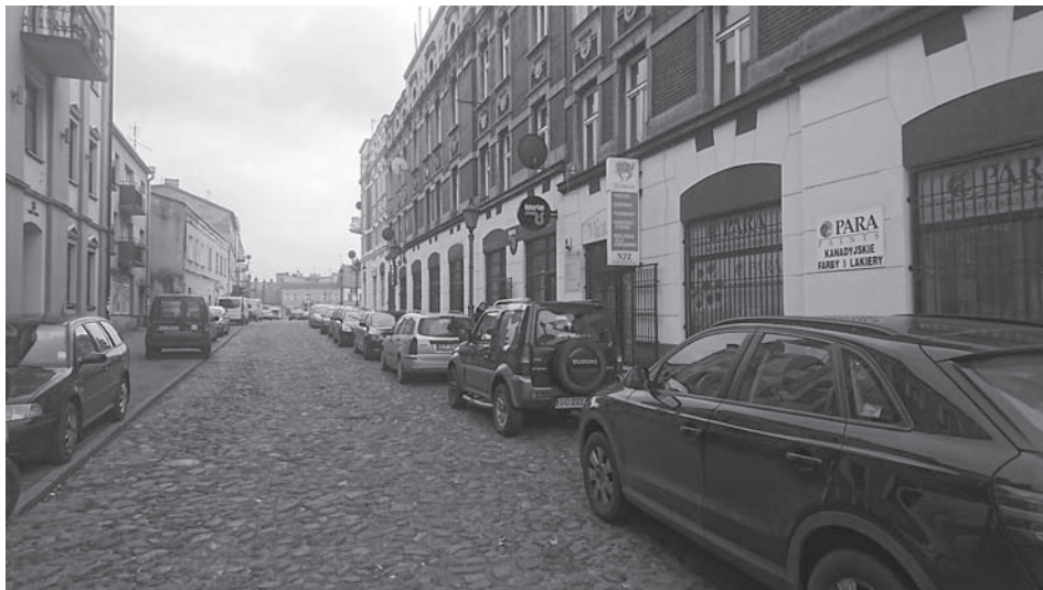
Fot. 10. Nawierzchnia z tzw. kocich łbów (kamień polny) ulicy w zespole staromiejskim Częstochowy, przykład ochrony nawierzchni oryginalnej, fot. S. Wróblewski 2017
