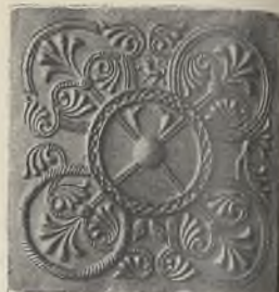
Abb. 40—44 u. 45—50. Mit Stempeln gepreßte rote Backsteine aus der Fabrik des Klosters St. Urban (Kt. Luzern). Zweite Hälfte des XIII. Jahrh. — Nach Photographien des Schweiz. Landesmuseums in Zürich.
