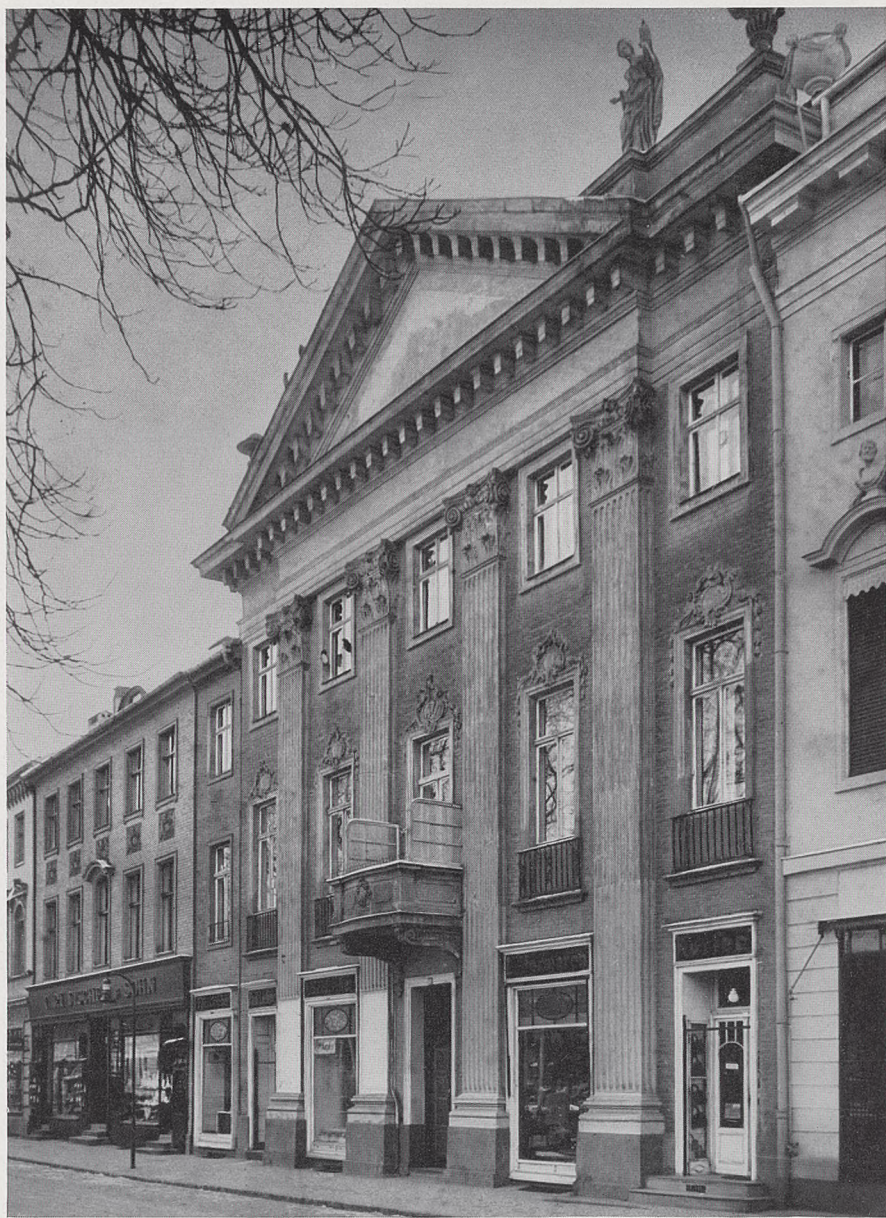
79. AM KANAL GEGENÜBER DEM WILHELMPLATZ. DAS HAUS NR. 41 1756 VON MANGER ALS PROBE FÜR DAS NEUE PALAIS ERBAUT
