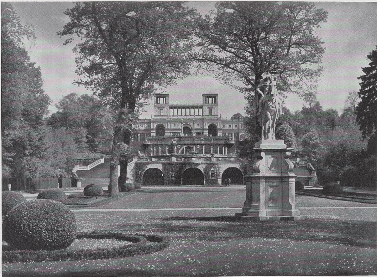
39. ORANGERIE, VORN: VERKLEINERTE WIEDERHOLUNG IN MARMOR DES BERLINER DENKMALS FRIEDRICH DES GROSSEN VON RAUCH (1865)
