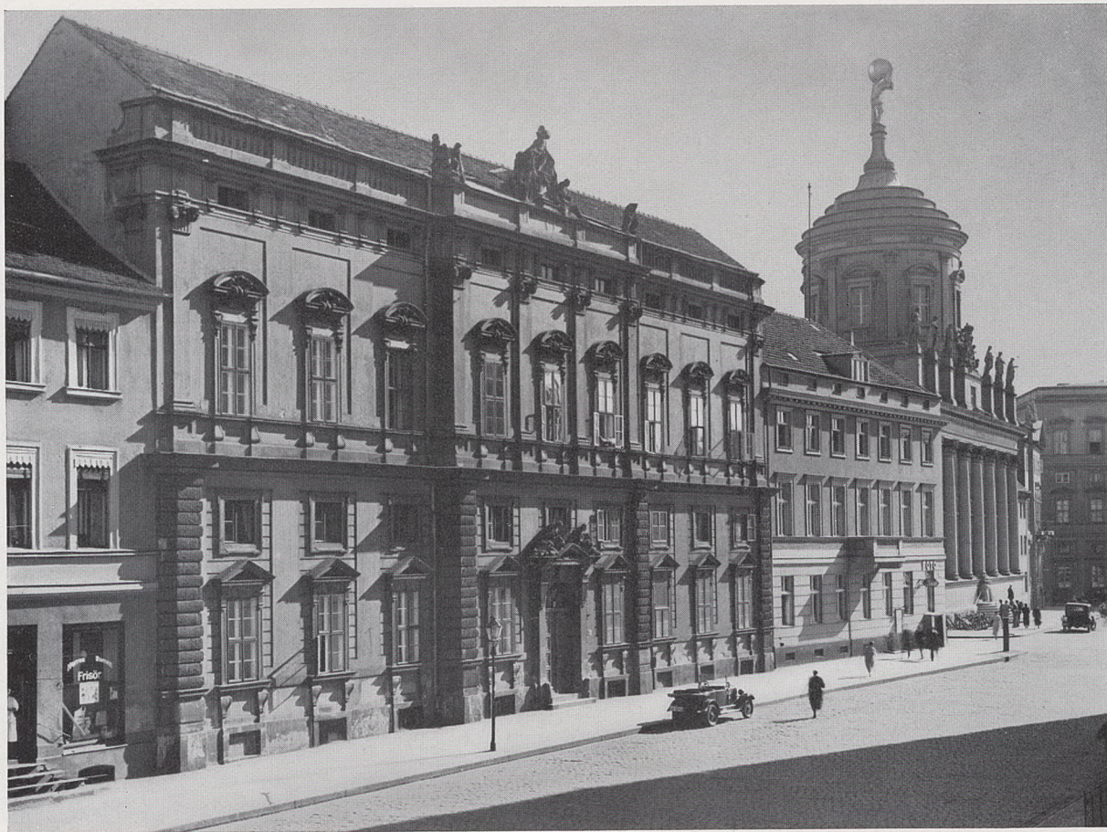
75. ALTER MARKT, OSTSEITE, LINKS PREDIGERHAUS DER NIKOLAIKIRCHE, 1752 (KOPIE DES PALAZZO DELLA CONSULTÀ IN ROM), RECHTS RATHAUS VON BOUMANN, 1753
