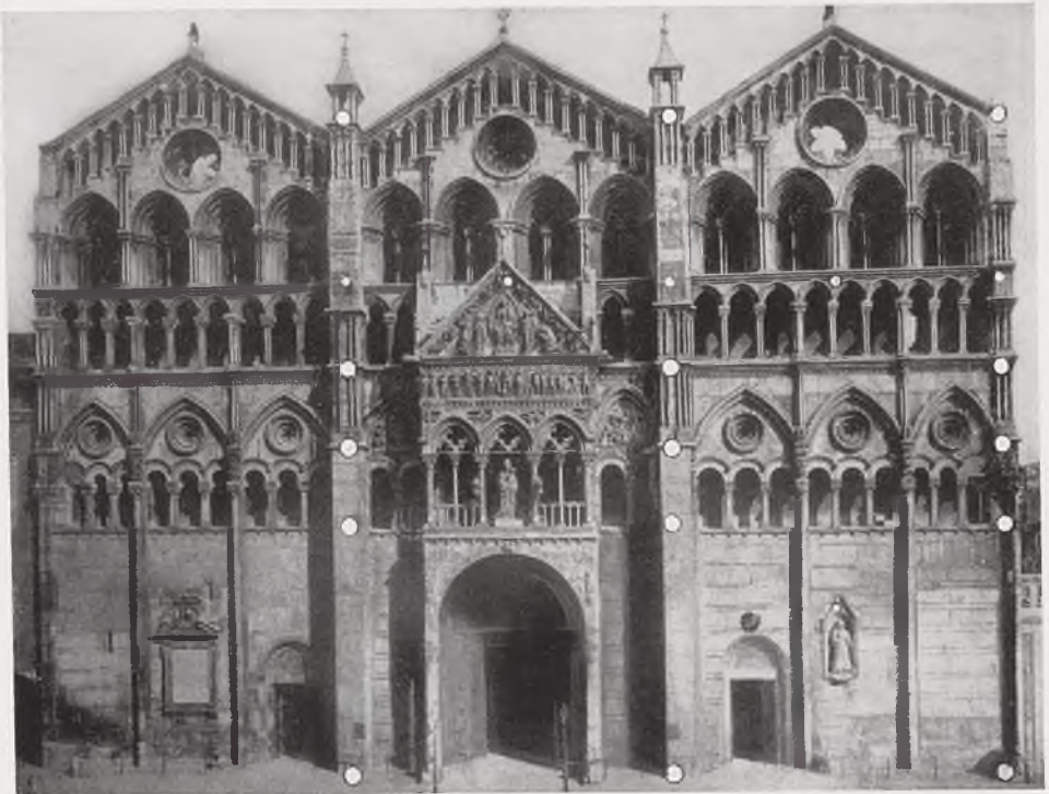
Tafel 66. Kathedrale von Ferrara. Die Schauseite ist dem Querschnitt ohne Rücksicht auf dessen Maße und Maßverhältnisse vorgebaut. Sie besteht aus drei gleichen Elementen. Es sind Rechtecke, deren Höhe sich zur Breite verhält wie 2 : 1. Die Höhe der Giebelspitze entspricht dem Wert der Diagonale des Rechtecks ( \sqrt{5} ). Die Höhenstufung entspricht der Teilung, welche sich aus dieser Grundlage ableiten läßt
