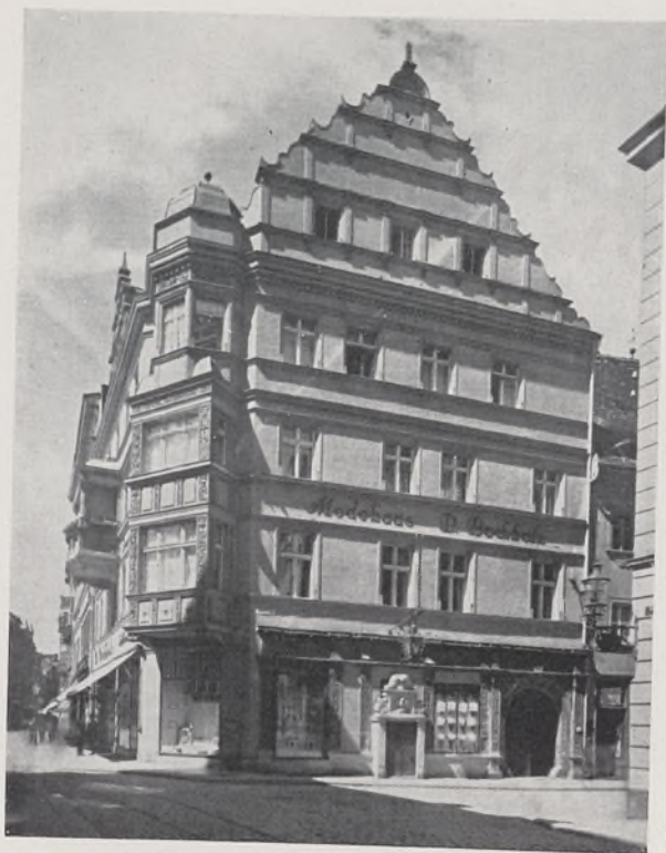
Stadtschreiberhaus (D. Buchholz) Erneuert von Heider & Günther, Liegnitz
