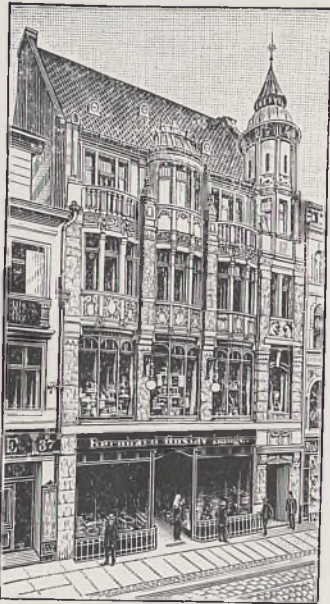
Geschäftshaus Goldberger Straße
