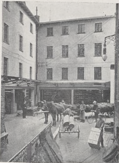
Hof und Lagerhäuser, Pfortenstr. 1/2, mit Stabeisenlager
