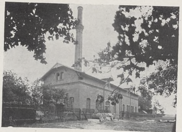
Wasserwerk Liegnitz, Maschinenhaus Heegerwiese
