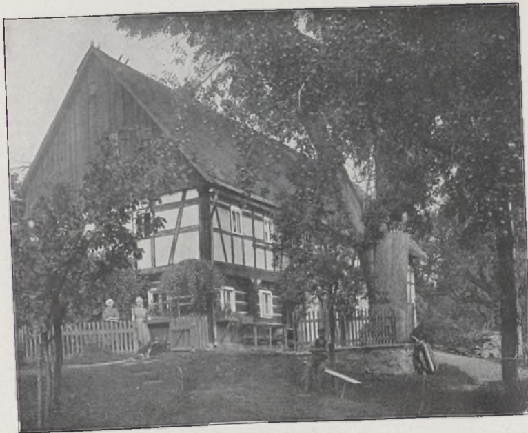
Haus eines Stellenbesitzers im oberen Katzbachtale (Wohnräume Schrotbau, Stallung Mauerwerk, Scheuer [rechts] und Oberstock Fachwerk, Strohdach)
