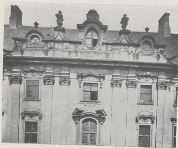
Mittelbau des Jesuitenseminars vor der Erneuerung
