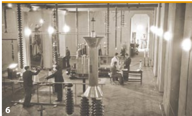
Drugie laboratorium wysokich napięć w budynku A-1 [6]
