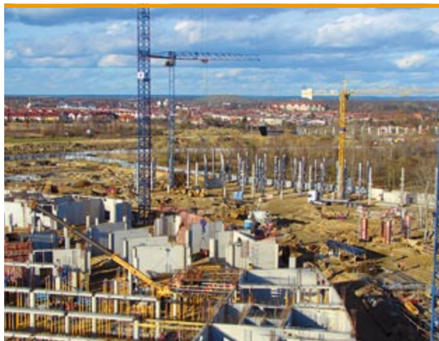
Przedstawiciele Spółki Wrocław 2012 zapewniali, że prace na stadionie idą pełną parą
