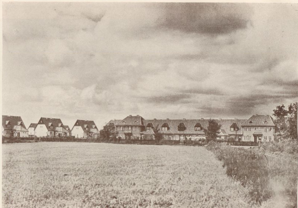
Staatliche Kleinhaus-Siedlung in Nord-Langenhorn (Arch. Schumacher)
