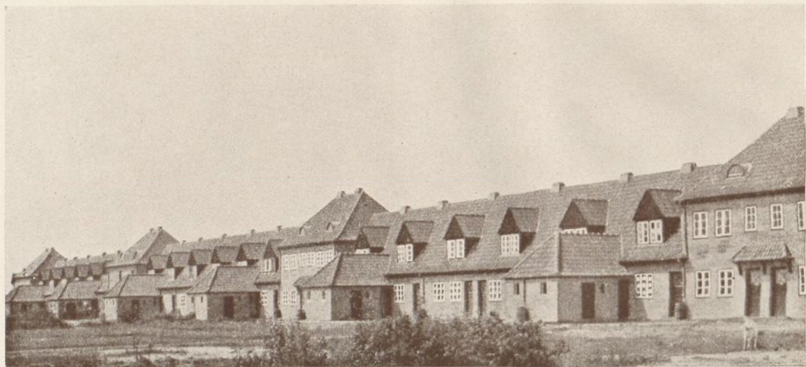
Siedlung Nord-Langenhorn. Beispiel der Zeilenbauweise
