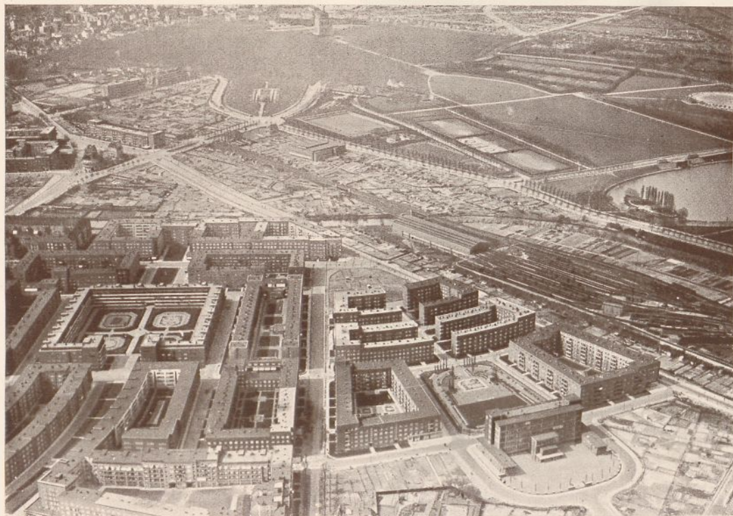
Gesamtansicht des Baugebietes südlich vom Stadtpark
