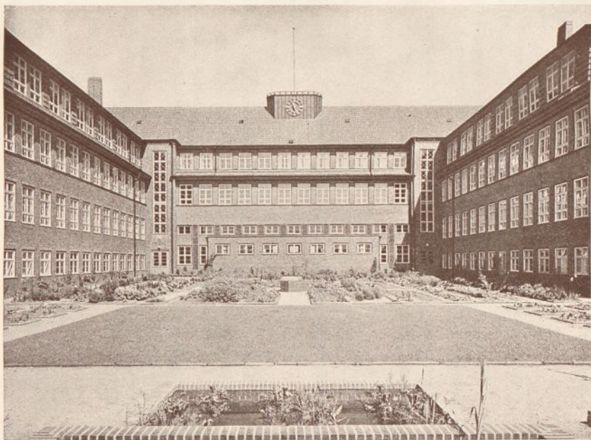
Siedlungsschule in Nord-Langenhorn. Offener Hof. (Arch. Schumacher)
