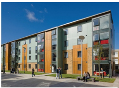
Rys. 45 Eco Residence Cluster Houses. Widok z zewnątrz. Fot. dzięki uprzejmości Lancaster University
