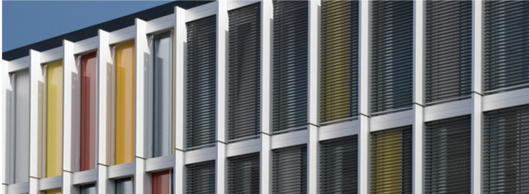
Rys. 195 Przesłony pionowe wkomponowano w fasadę budynku. Zastosowano również zewnętrzne aluminiowe żaluzje. Źródło internetowe: https://www.architectsjournal.co.uk/buildings/specification/external-blinds/8636859.article , dostęp 01.09.2018.
