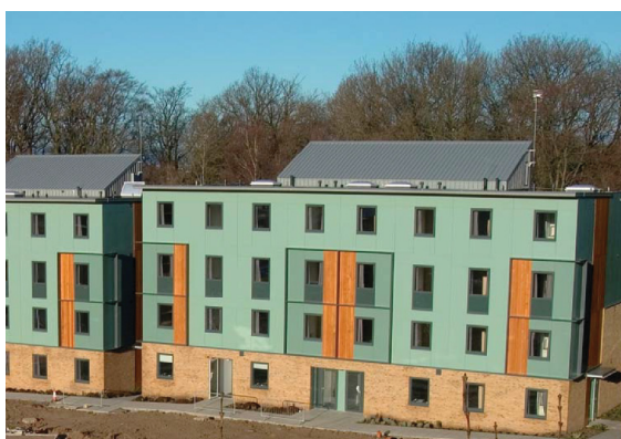
Rys. 43 Eco Residence Town Houses. Widok z zewnątrz. Fot. dzięki uprzejmości Lancaster University
