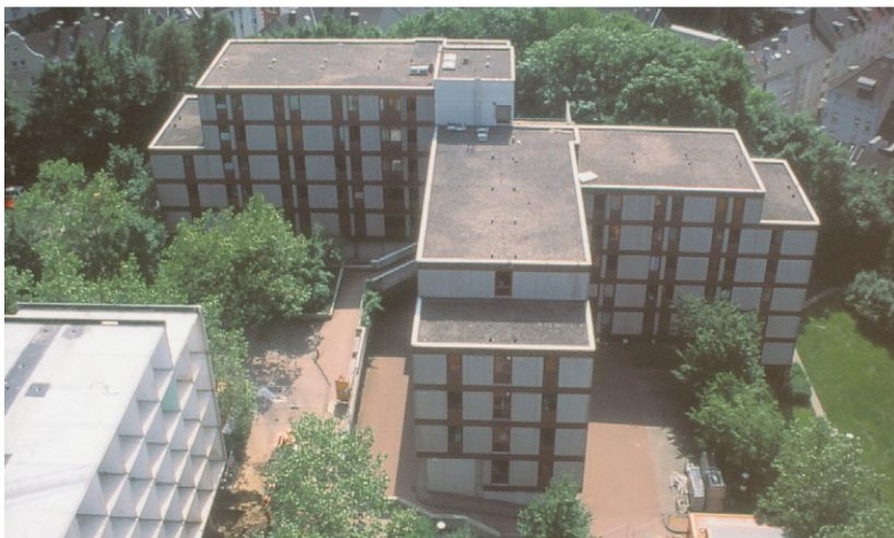
Rys. 84 Zespół Neue Burse przed modernizacją, źródło internetowe: http://enob.pse.de/projects/62/photos/ , dostęp: 20.02.2018
