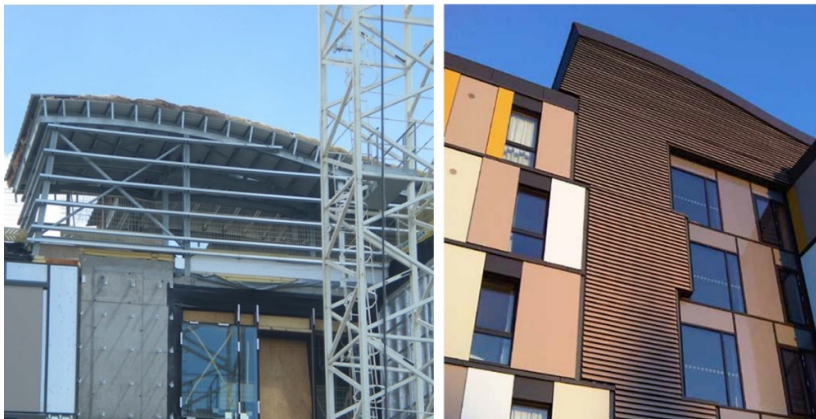
Rys. 74 Elementy fasady w czasie konstrukcji i po jej wykonaniu, źródło internetowe: http://www.nypassivehouse.org/wp-content/uploads/2017/12/Kavanagh_Live-PH-Student-Housing_NY14PH.pdf , dostęp:31.03.2018
