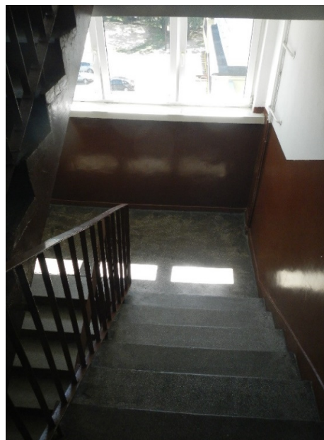
Rys. 128 Klatka schodowa, fot. Mokrzecka M.
