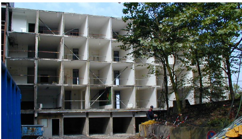
Rys. 85 Zespół Neue Burse w trakcie modernizacji, źródło internetowe: http://enob.pse.de/projects/62/photos/ , dostęp: 20.02.2018
