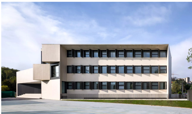
Rys. 198 Szkoła w Navarze, Hiszpania, https://divisare.com/projects/268682-otxotorena-arquitectos-jose-manuel-cutillas-ruben-p-bescos-new-building-in-el-redin-high-school źródło internetowe: https://divisare.com/projects/268682-otxotorena-arquitectos-jose-manuel-cutillas-ruben-p-bescos-new-building-in-el-redin-high-school , dostęp: 01.09.2018
