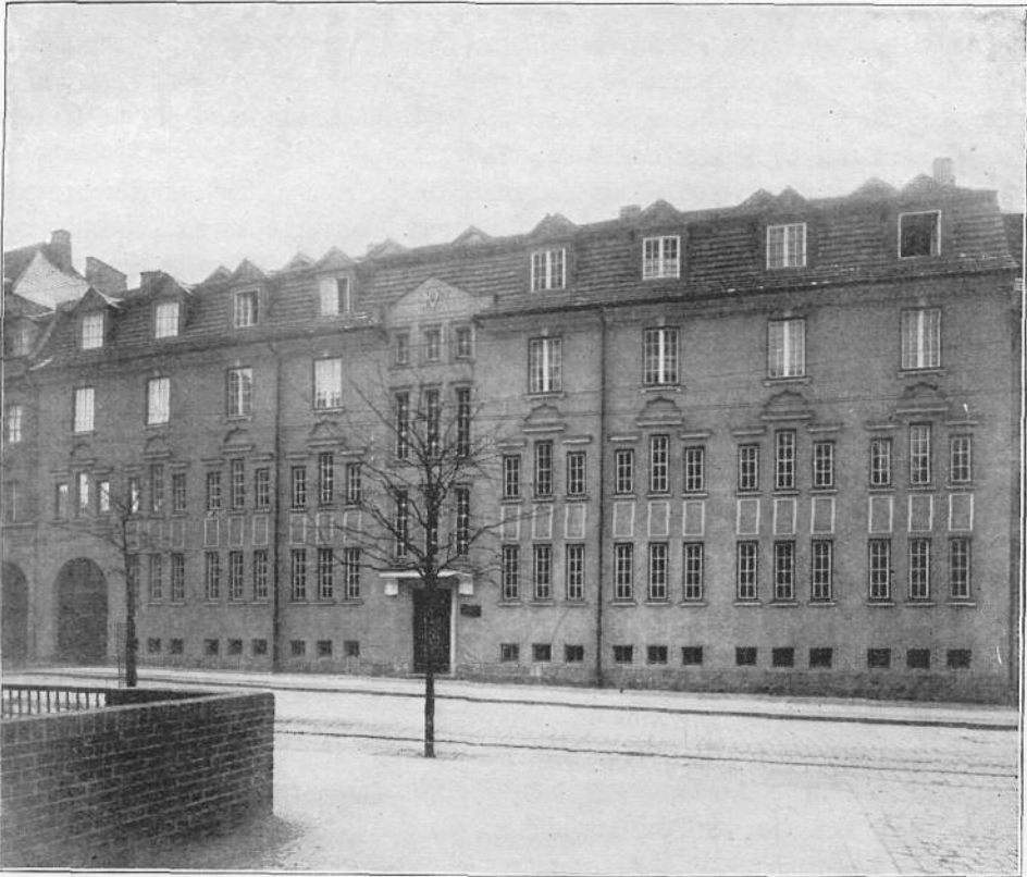
Verwaltungs- und Betriebsgebäude
