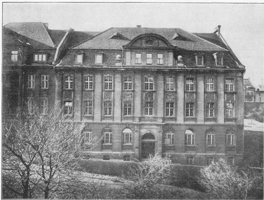
Geschäftsgebäude des Niederschlesischen Steinkohlen-Syndikats G. m. b. H., Waldenburg in Schlesien, Freiburgerstraße 20 a
