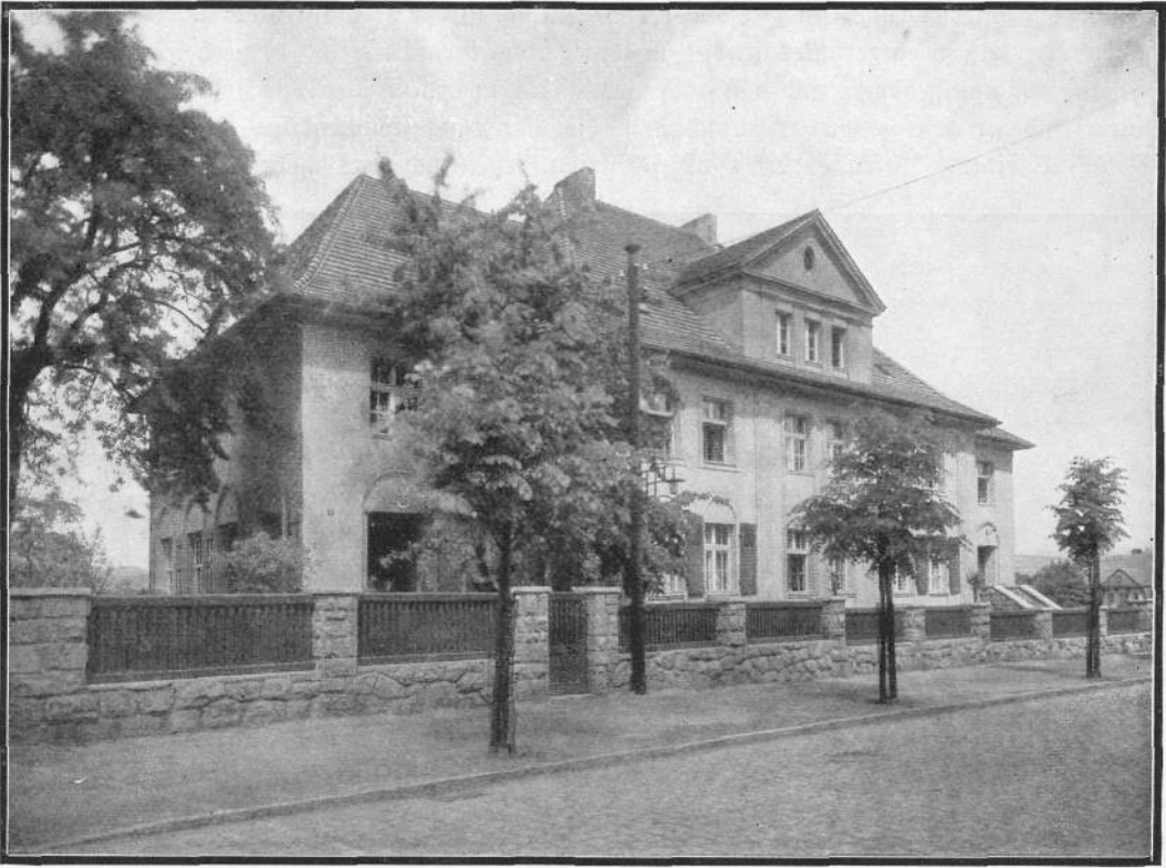
Wohnhausneubau an der Barbarastraße
