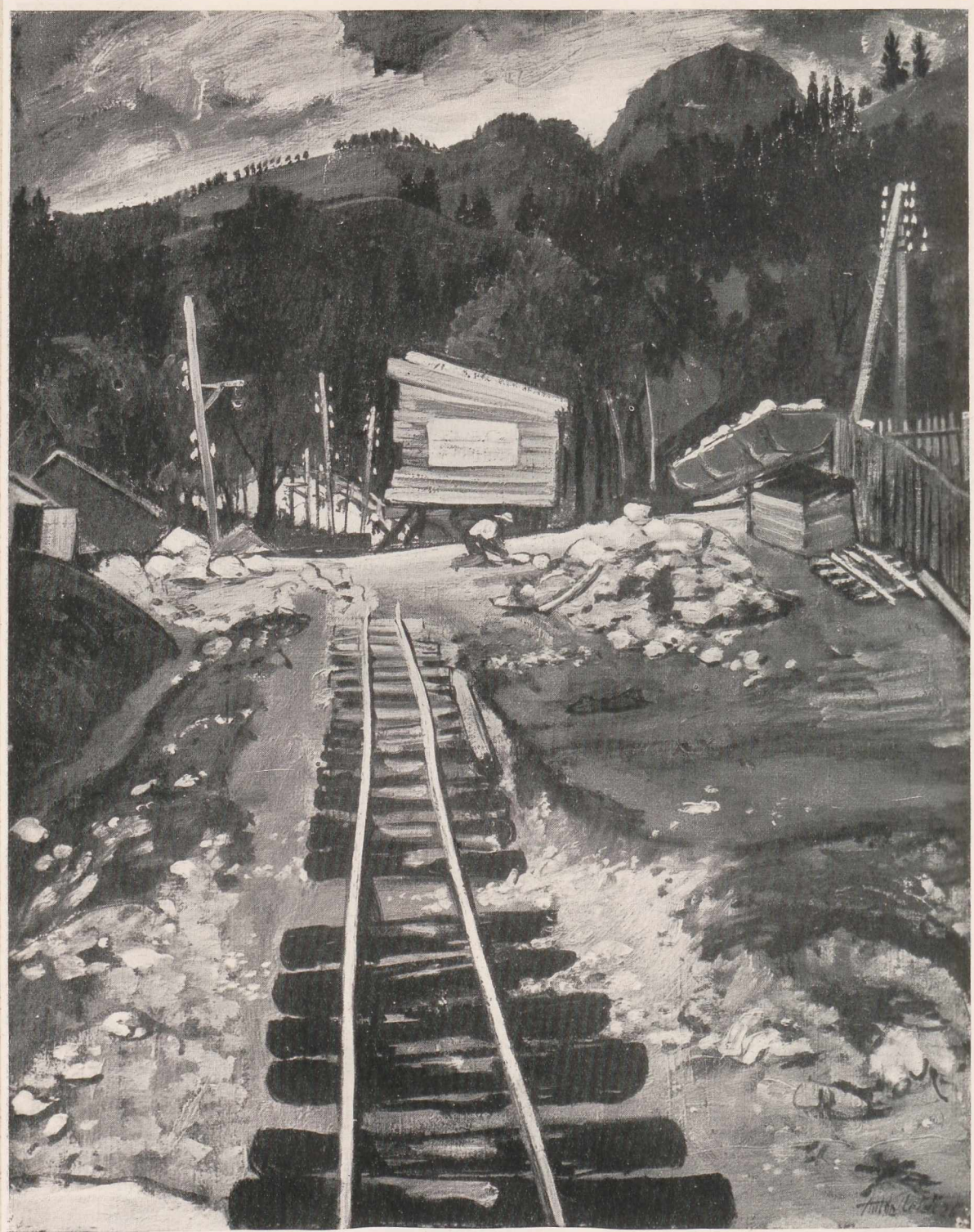
Baustelle bei Bayrischzell Gemälde von Anton Leidl-München
