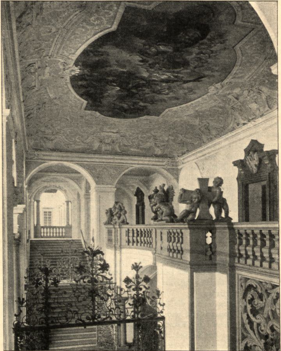
Vom Treppenhause des Stiftes St. Florian zu Wien.
