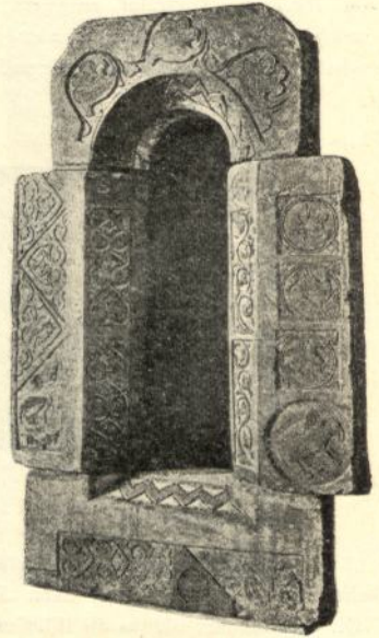
Fensterumrahmung in der Kirche zu Grofsdietwil 102) .
