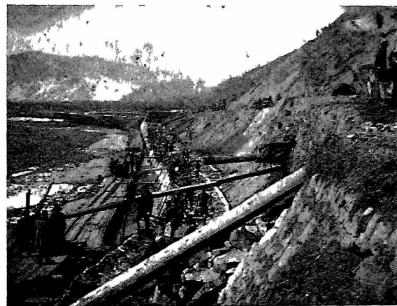
Ryc. 7. Budowa kolejki — mur oporowy powyżej Kut.
