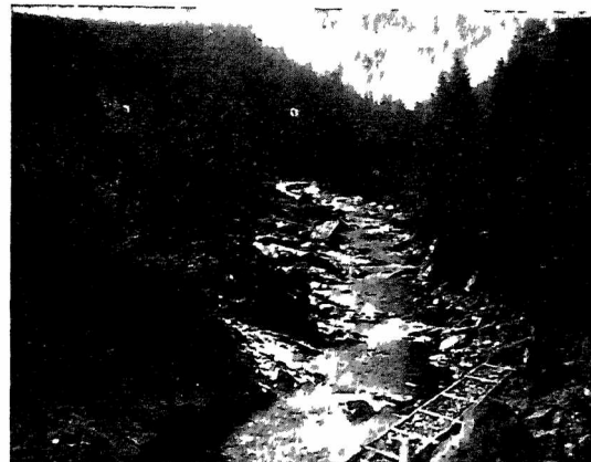
Ryc. 19. Przełom Prułu t. zw. „Worocia“ ubezpieczony w zakolach kaszycami, bardzo niebezpieczny dla spławów.
