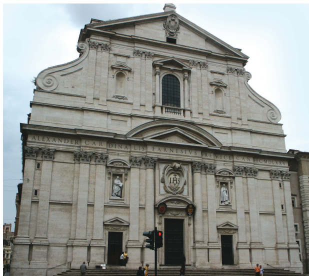
Il. 1. Fasada kościoła Il Gesù (proj. C. Maderno, 1584) (fot. S. Wróblewski)
