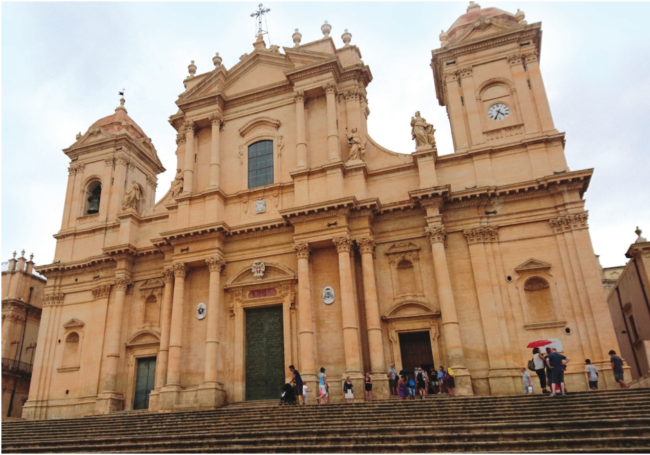
Il. 3. Fasada katedry S. Nicolò w Noto projektu R. Gagliardiego z lat 1667–1740 (fot. S. Wróblewski)
