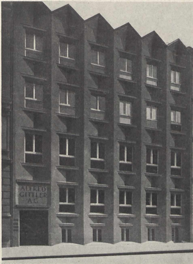
1. Umbau eines Mietshauses in ein Bürohaus. Breslau (1923)
