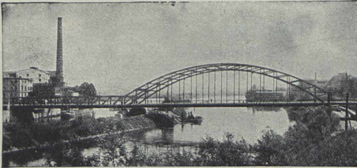
Oderbrücke (Hindenburgbrücke) in Glogau
