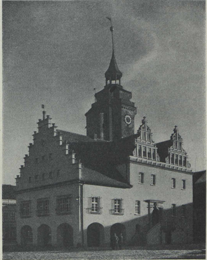
12. Das Rathaus in Prausnitz, ein Bau der Renaissance, nach seiner Wiederherstellung
