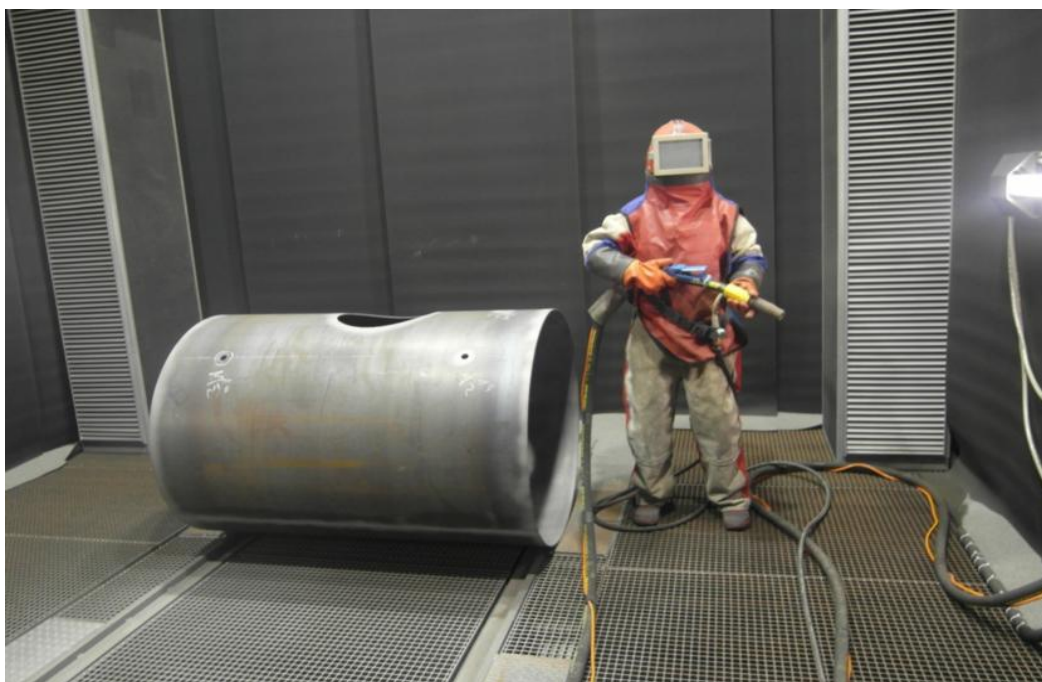
Rys . 14.a. Konstrukcja płaszcza zbiornika ciśnieniowego śrutowana kabinowo [143].
