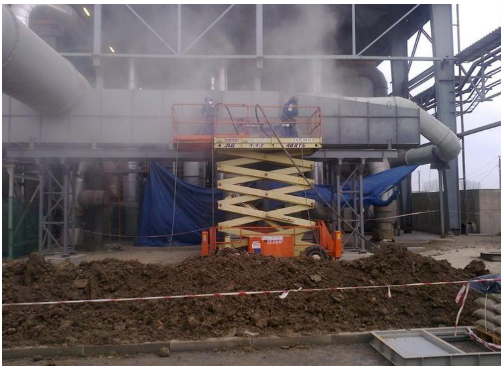
Rys. 1. Prace antykorozyjne, krycie śrutem miękkim elementu instalacji odsiarczania spalin na terenie Elektrowni Belchatów.
