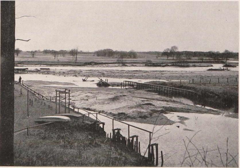
Durchbruch der Görlitzer Neiße bei Penzig - Blick von der Badeanstalt auf die durch Sand- und Schotterablagerung zum Totarm gewordene Schlinge. Im Hintergrund das neue Flußbett
