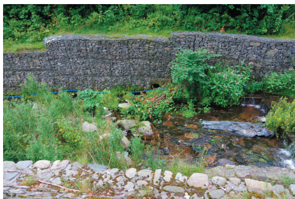
Ryc. 9. Miejsce w którym znajdowało się okno sztolni „Jedlica” według stanu z 1.04.2017 r. (fot. D. Wójcik)
