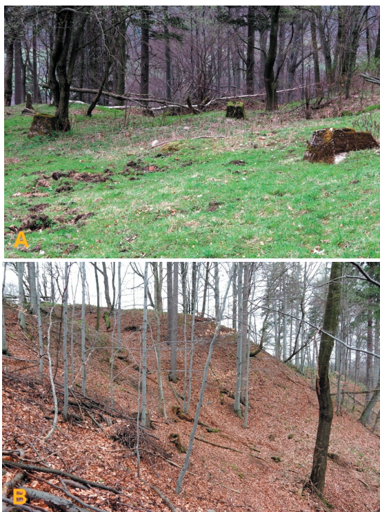
Ryc. 19. Szyb nr 4, (A) betonowe podpory wieży wyciągowej; (B) hałda (obie ryciny – stan z 8.04.2017 r., fot. D. Wójcik)
