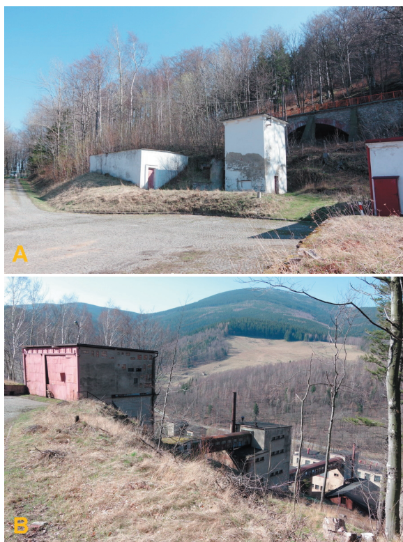
Ryc. 10. Szyb „Pochyły” (A) pozostałości nadszybia; (B) fragment hałdy z budynkiem zsypu (obie ryciny – stan z 1.04.2017 r., fot. D. Wójcik)
