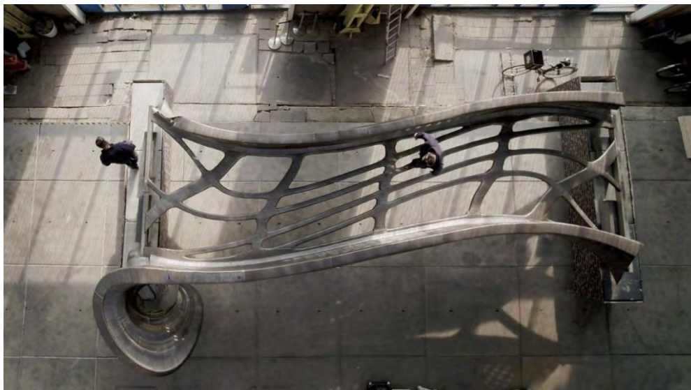
fol. 44: Stalowy most w całości wyprodukowany za pomocą drukowania 3d. MX3D, Amsterdam.
