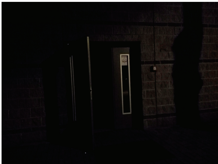
Rys. 13. Drzwi do hali tenisowej w porze nocnej. Źródło: Opracowanie własne
