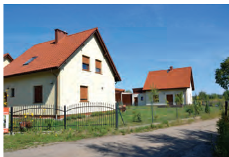
Rys. 5.3. Osiedle domków jednorodzinnych na terenie po eksploatacji ilów
