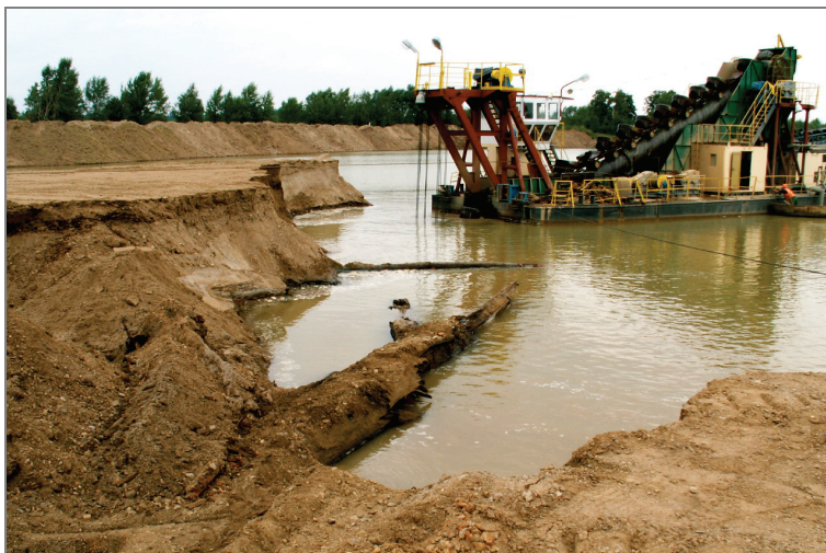
Fot. 16. Wrocławskie Kopalnie Surowców Mineralnych – Zakład górniczy „Pilce”, pogłębiarka wielonaczyniowa PK-300 (fot. z zasobów OUG)
