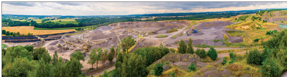
Fot. 35. Panorama Zakładu Górniczego Sulików eksploatującego bazalt na kruszywo, woj. dolnośląskie, (z zasobów OUG)
