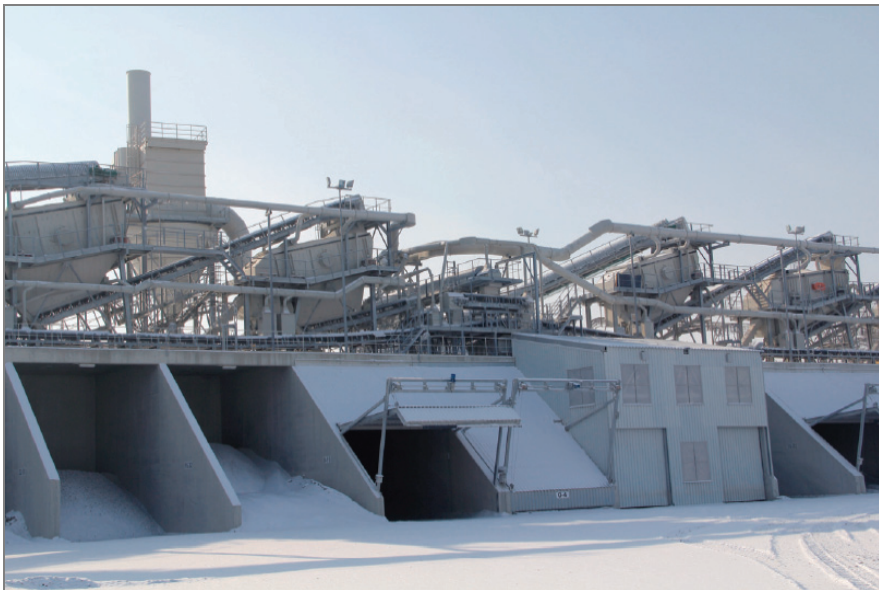
Fot. 37. Zakład Górniczy Wieśnica hermetyzacji magazynów gotowego produktu (fot. T. Wojtaszek)
