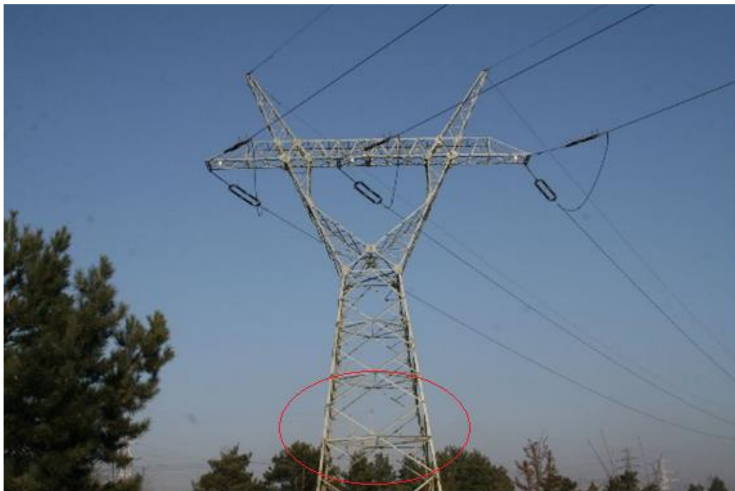
Rys. 6.4. Przykładowe zdjęcie obiektu rzeczywistego z zaznaczonym fragmentem z którego usunięto elementy
