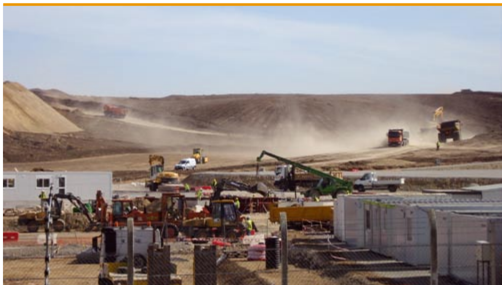
Plac budowy reaktora ITER, Cadarache w Prowansji
