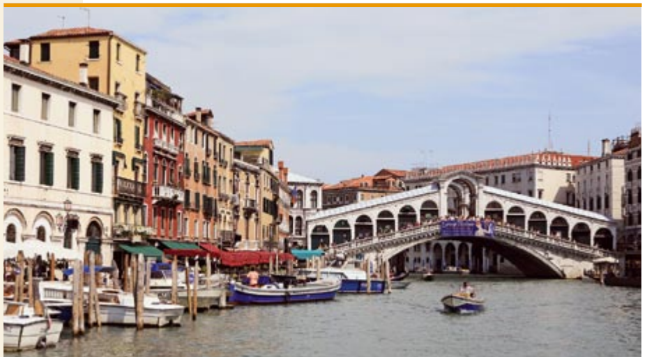
Ponte di Rialto
