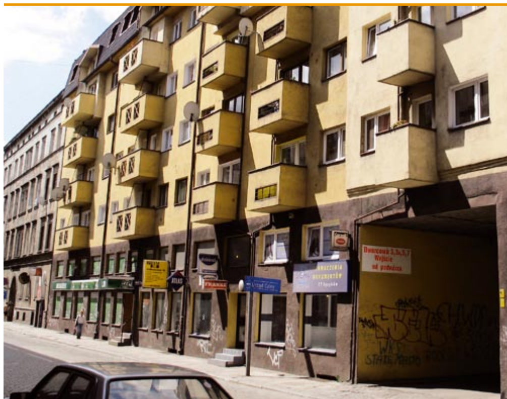
Dom przy ul. Dworcowej 7 we Wrocławiu; w oficynie domu stojącego niegdyś w tym miejscu znajdowało się w latach 1857-1863 Biuro Politechniczne dr. Heinricha Schwarza
