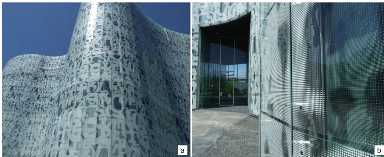
Il. 5. Budynek Biblioteki Uniwersyteckiej, Cottbus, Niemcy (Herzog & de Meuron, 2004): a) widok fasady, b) detal fasady, widok od strony wejścia (fot. A. Lipowicz-Budzyńska)
