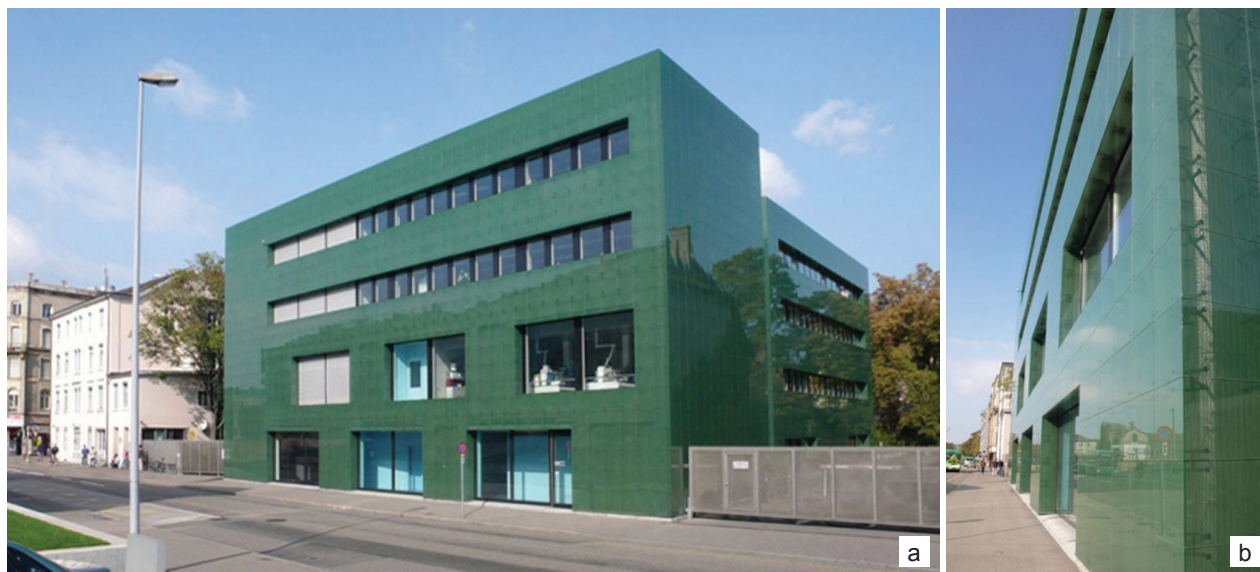
Il. 7. Budynek Institute for Hospital Pharmaceuticals, Bazylea, Szwajcaria (Herzog & de Meuron, 1998): a) część budynku od strony ulicy, b) budowa przegrody i obrazu (fot. E. Chakroff, źródło: [7])
