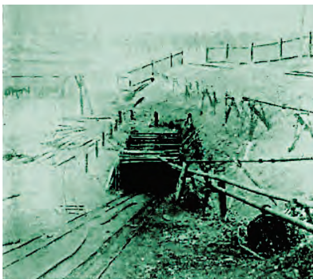
Ryc. 5. Wlot do Upadowej Staszic kopalni „Stanisław” (Kantor–Mirski, 1931) Fig. 5. The inlet to slope mine “Staszic” of the “Stanisław” mine (Kantor–Mirski, 1931)
