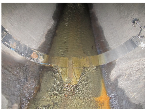
Rys. 3.7. Przepływomierz P1 typu Nivus PCM 4 zamontowany w studziencie nr 18 na kolektorze KD1 o średnicy 1,4 m; a) czujnik dolny, b) czujnik górny
