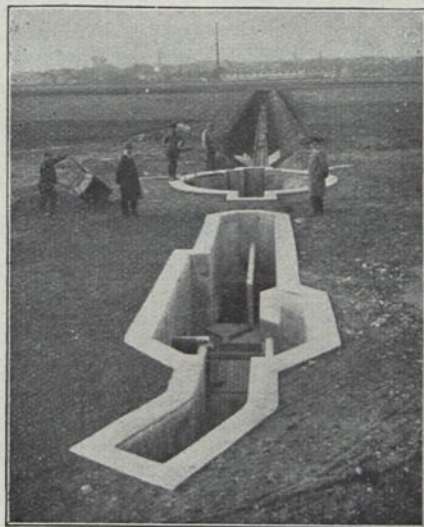
Abb. 1 Querschnitt durch die Frischwasser-Kläranlage Bauart OMS für die Siedlung Großporitsch bei Zittau
