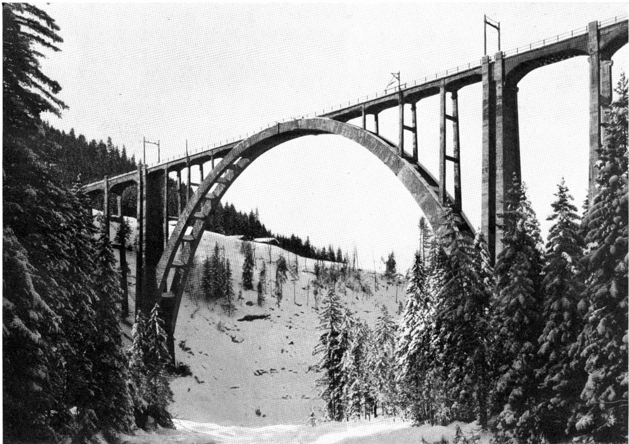
Abb. 245. Langwieserbrücke der Chur-Arosabahn (Ed. Züblin & Cie., Zürich). Vgl. Abb. 208
