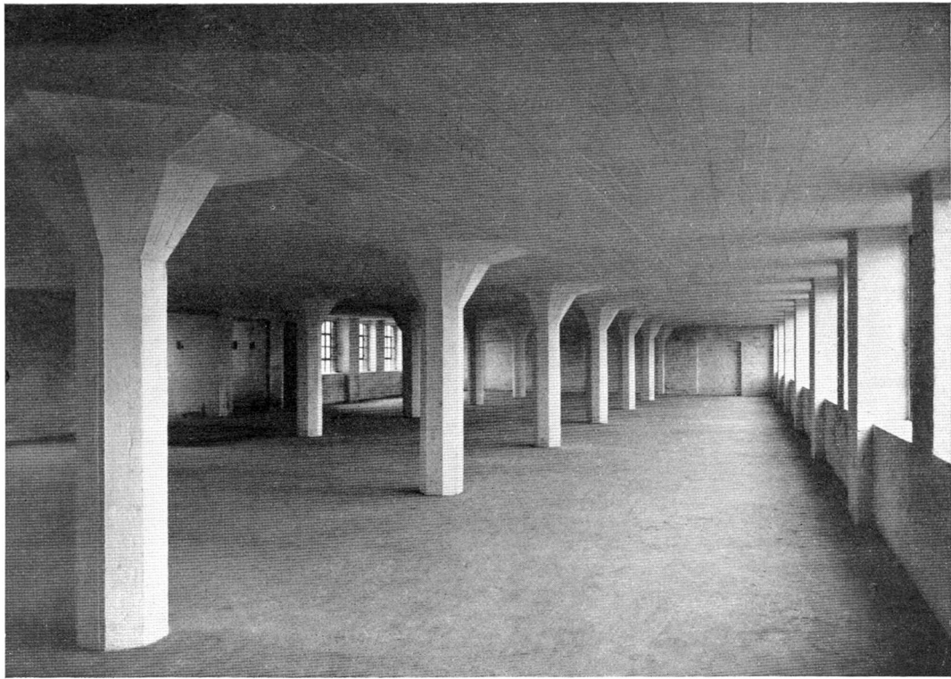
Abb. 117. Lagerhaus des Krausewerks, Neusalz a. O. (Dittmar Wolfsohn & Co., Breslau)
