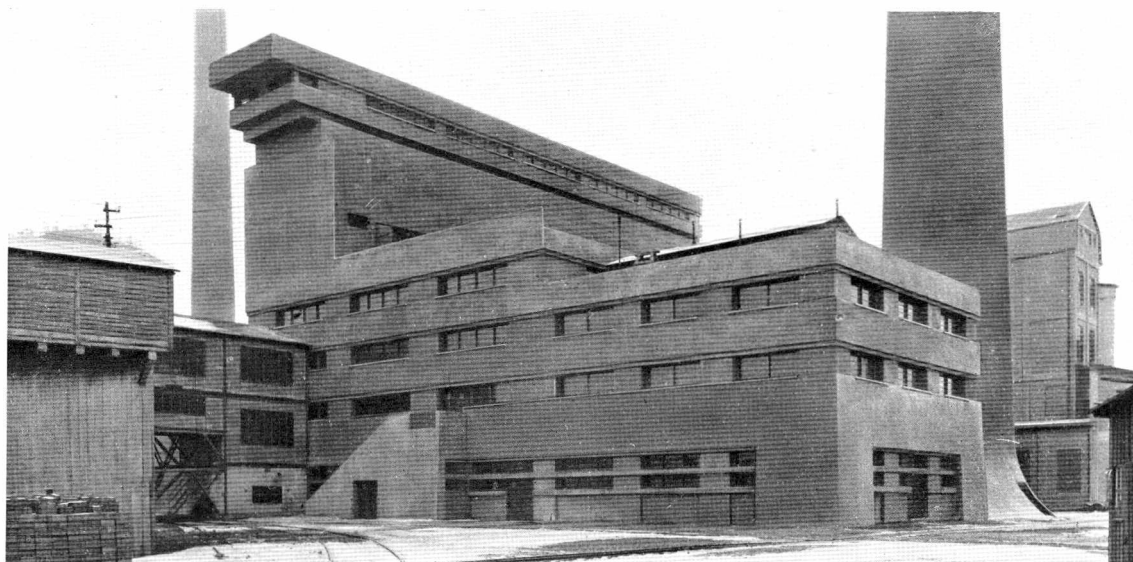
Abb. 175 Kobolyt- Cosse, Kesselhaus (Wayß & Freytag)
