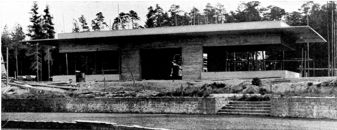
Abb. 150. O. E. Schweizer, Nürnberg: Sonnenbadkaffee im Stadion, Nürnberg (Emil Herbert, Nürnberg) Länge 26 m, Tiefe 8,6 m, Höhe 5,8 m. Mit 3 m auskragendem Vordach
