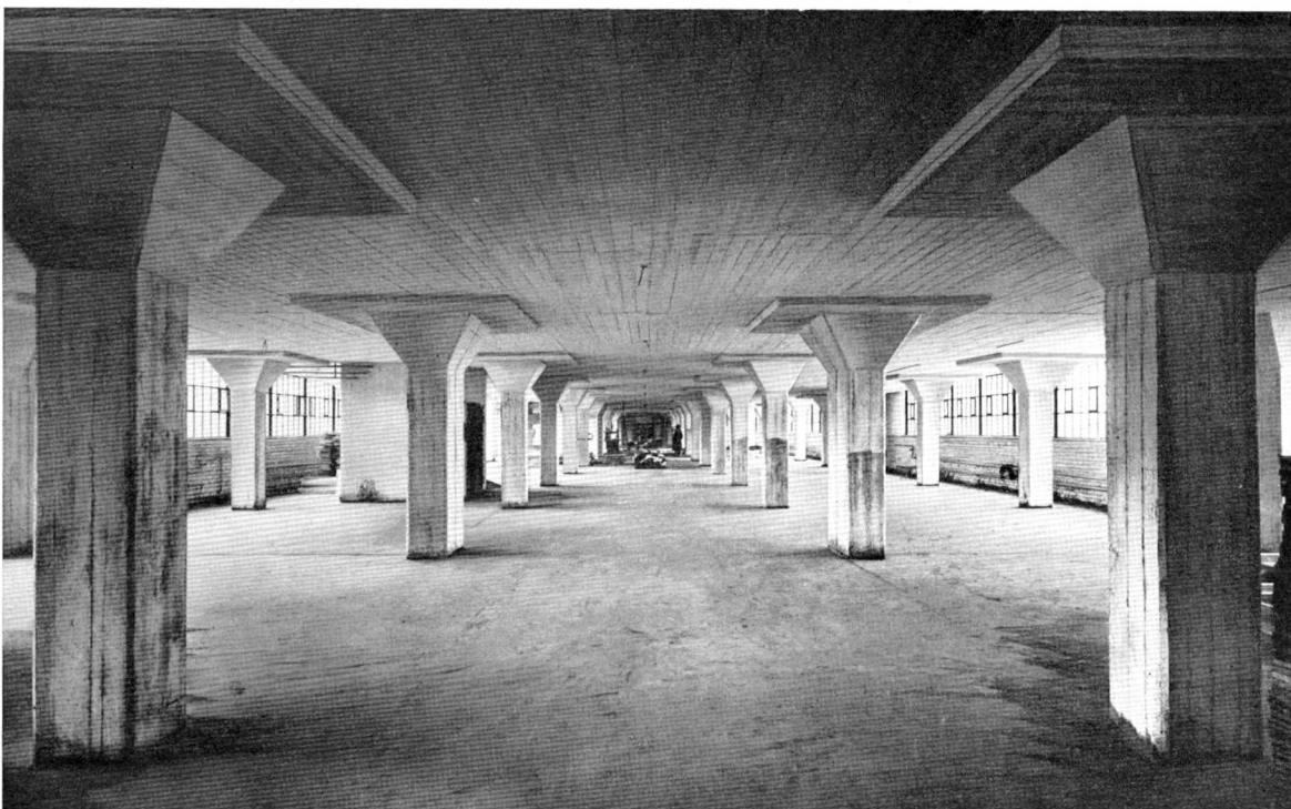
Abb. 116. Abel & Böhringer, Stuttgart-Köln: Lagergebäude Eisenfuchs, 1. Obergeschoß. (Ludwig Bauer, Stuttgart). Pilzdecke, äußerste Säulenreihe 2 m von der Wand, Decke mit Außenwand ausgekragt, Außenwand 12 cm Eisenbeton, zur Isolierung hintermauert Phot. Ph. Sporrer. Vgl. Abb. 124 a, b und c)
