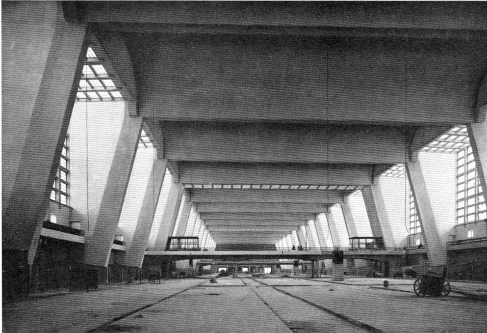
Abb. 108. Martin Elsaesser (Städt. Hochbauamt): Großmarkthalle Frank- furt a. M. (Dyckerhoff & Widmann mit Ed. Züblin & Cie). Innenansicht. Hauptstelle 11.300 m 2 . Stützenabstand 14,1 m, Spannweite 44 m, Scheitelhöhe 29 m
