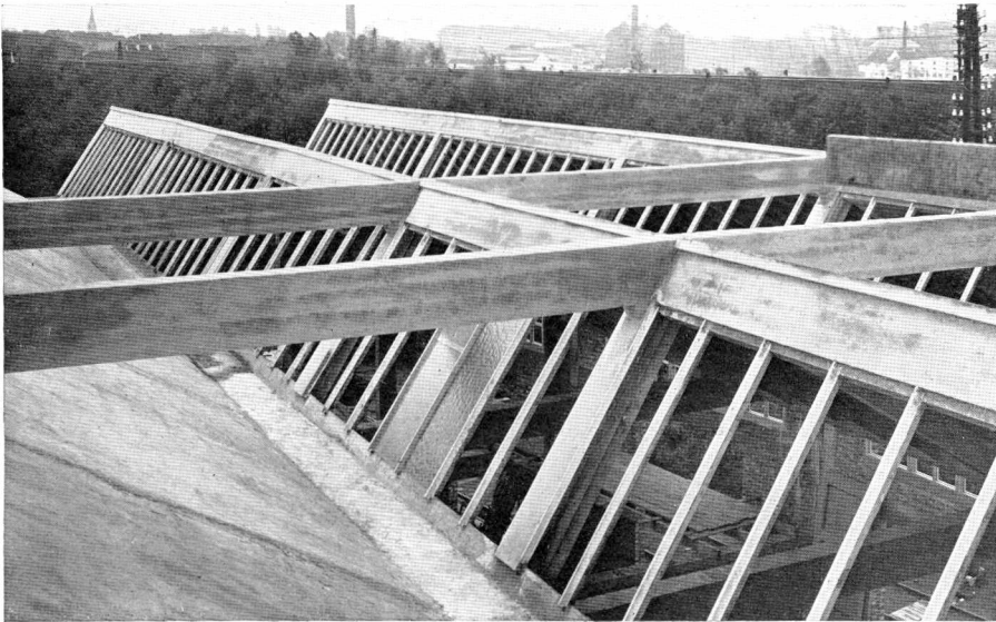
Abb. 81. Neuaufbau eines Oberlicht-Daches der Gerberei in Saventhem, Belgien (Le Châssis de Vitrage, Lille)
