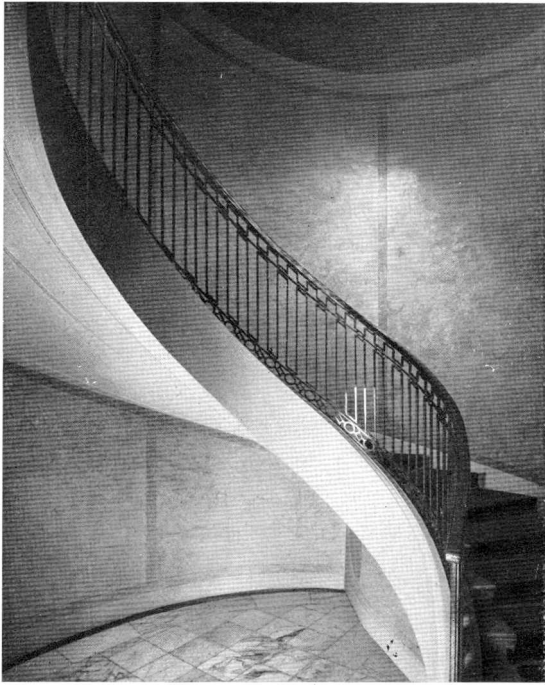
Abb. 125. Gewendelte Eisenbetontreppe im ehem. Hoftheater in Weimar. (Rud. Wolle, Leipzig, 1907)
