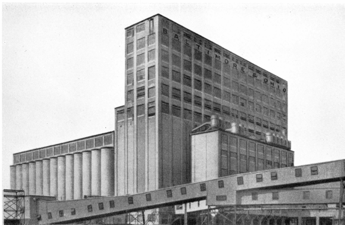
Abb. 226. Metcalf & Co., Baltimore: Getreide-Elevatoren der Baltimore & Ohio R. R. Phot. Portland Cement Association
