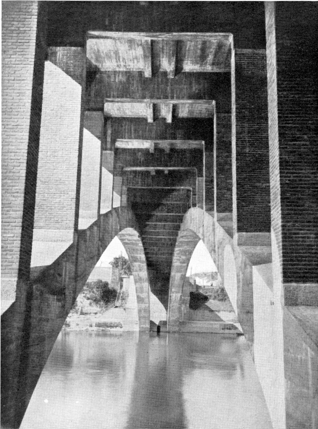
Abb. 251. Limousin, Paris: Untersicht der Lot-Brücke bei Villeneuve (Vgl. Abb. 240)
