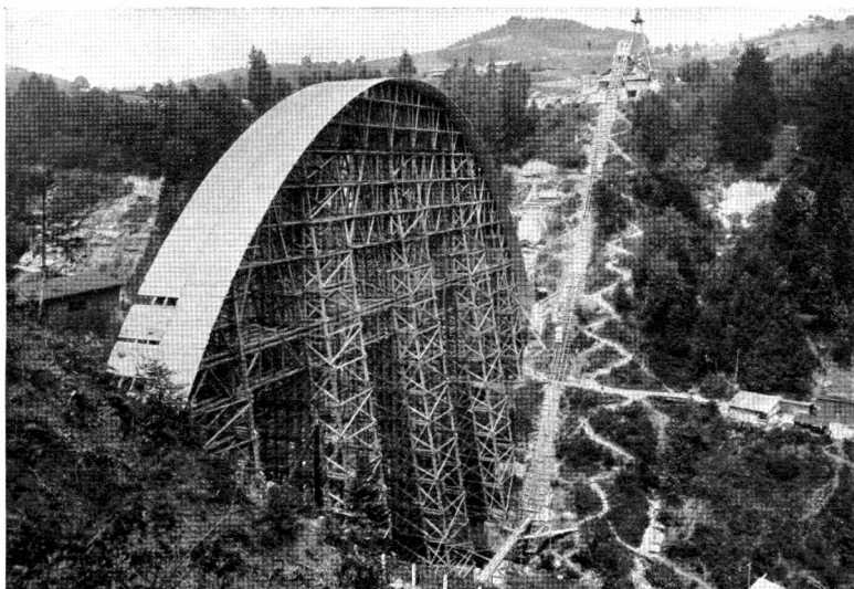
Abb. 248 50. Hundwilertobel-Brücke, Appenzell (Ed. Züblin & Cie.). Gesamtlänge 220 m, Spannweite des Gewölbes 105 m, Fahrbahn 69 m über dem Fluß Gesamtmasse 6016 m 3 . Dazu Lehrgerüst und Schalung des Gewölbes und Ansicht des betonierten Gewölbebogens
