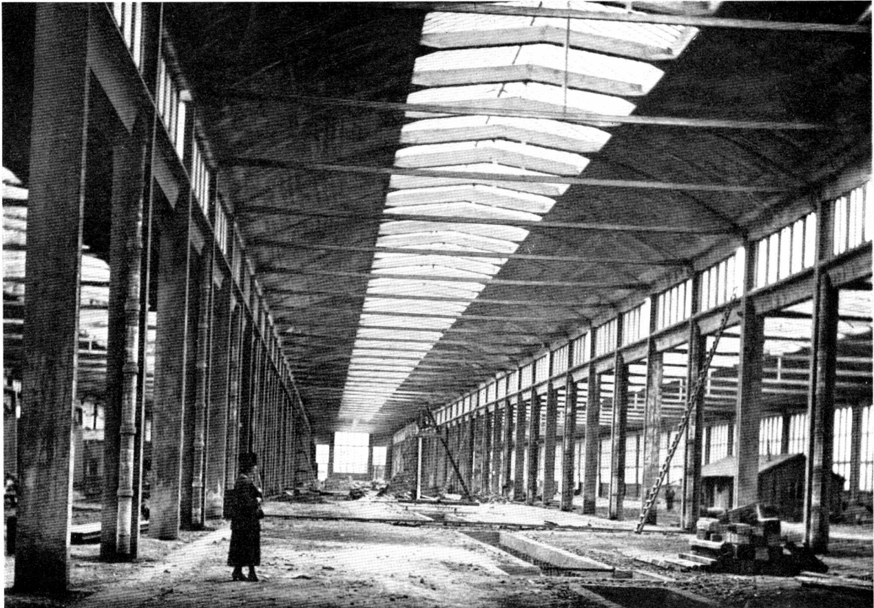
Abb.102. Freyssinet: Fabrikhalle in Grocy. (Limousin, Paris). Phot. Dr.Stoedtner. Grundfläche 22000 m 2 , Höhe 20 m
