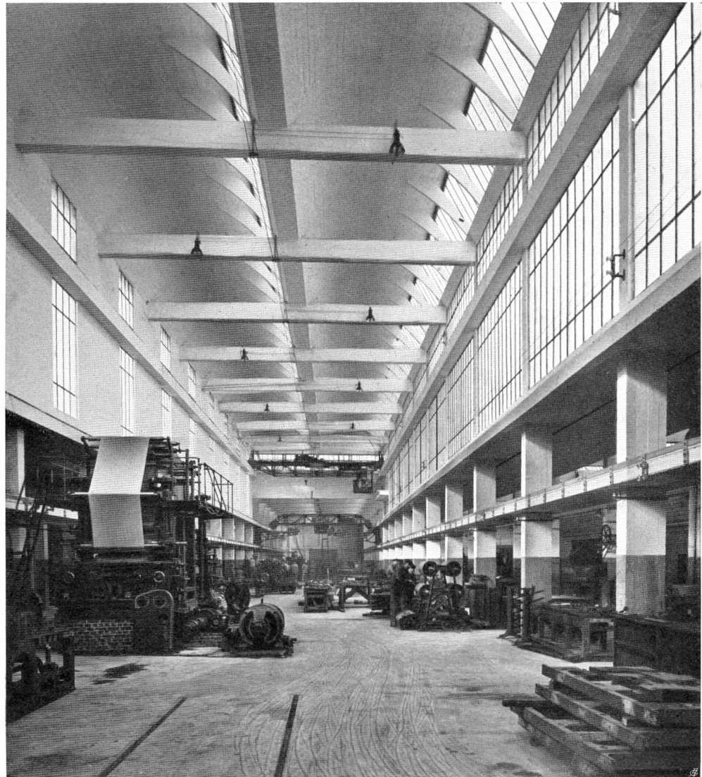
Abb. 82. Perret Frères, Paris: Marinoni-Werke in Montataire. Parabolisches Sheddach Höhe 13 m
