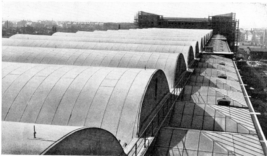
Abb.106. Martin Elsaesser (Städt. Hochbauamt): Großmarkthalle Frankfurt a. M. Baufaufnahme der auf schrägen Stützen ruhenden Tonnengewölbe. (Vgl. Abb. 87, 88)
