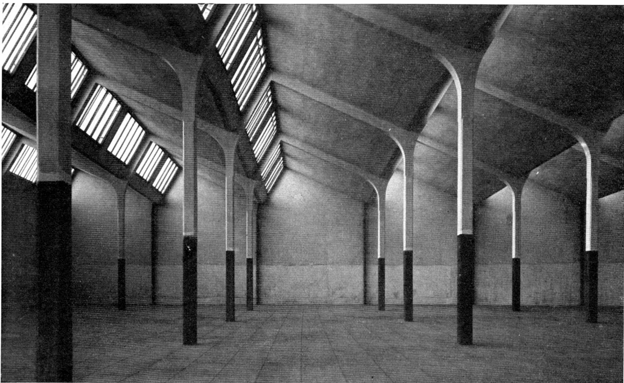
Abb. 77. Spinnerei Benet, Barcelona. (Maillart & Cie., Genf). Shedbau mit 5 m Säulenabstand ohne Zugband Abb. 78. Spinnerei Benet, Barcelona. (Maillart & Cie., Genf)
