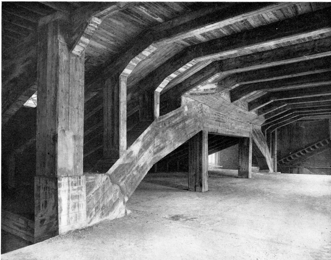
Abb. 47. Ufapalast Stuttgart. Untersicht des Amphitheaters. (Ludwig Bauer, Stuttgart.) Die Rahmenkonstruktion leitet den Druck auf die Eckpfeiler. An den Mittelsäulen hängt die Eisenbetonkonstruktion der Untergeschosse. Phot. Dr. Lossen & Co.
