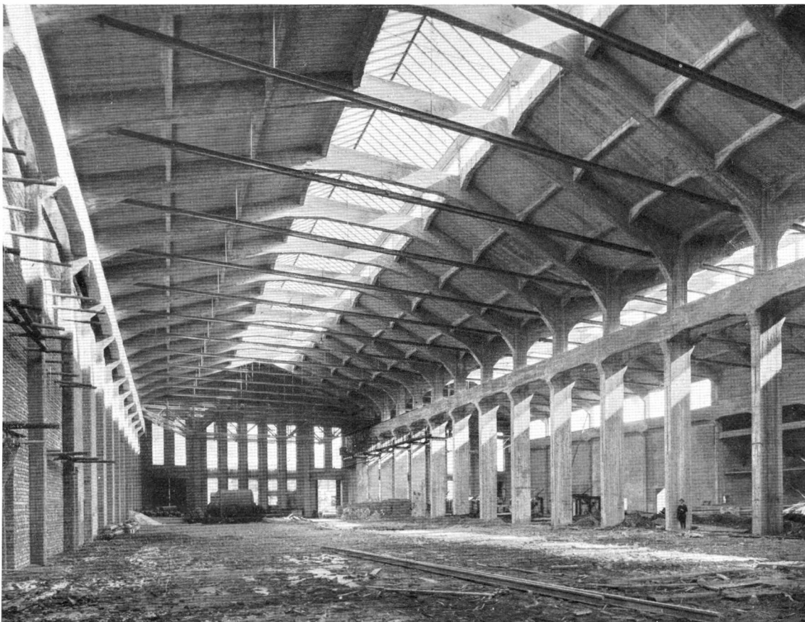
Abb. 68. Schmiede der Loko- motivfabrik Jungenthal (Heinrich Bützer, Dortmund) 100 m lang, 75 m Ge- samtbreite, lichte Höhe 17,5 m
