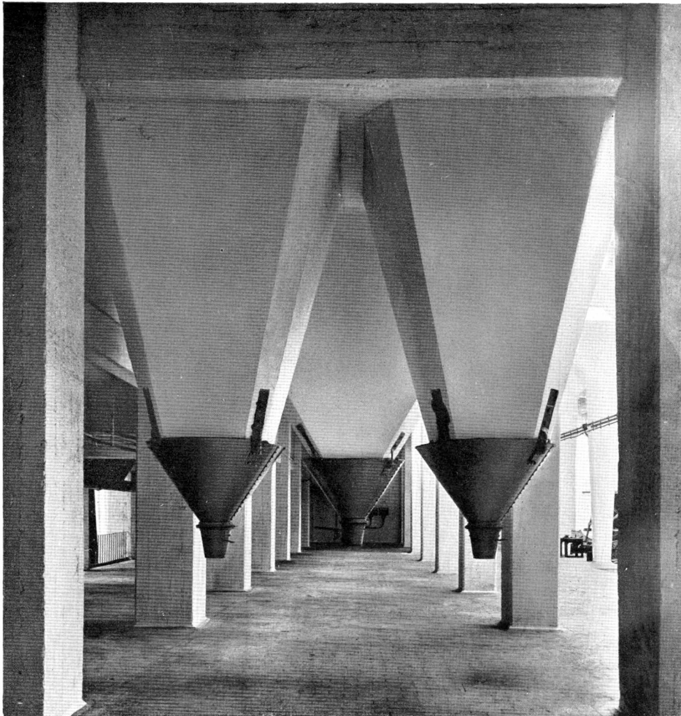
Abb. 133. Zuckerraffinerie Tangermünde Auslauftrichter der Silos (Dyckerhoff & Widmann)
