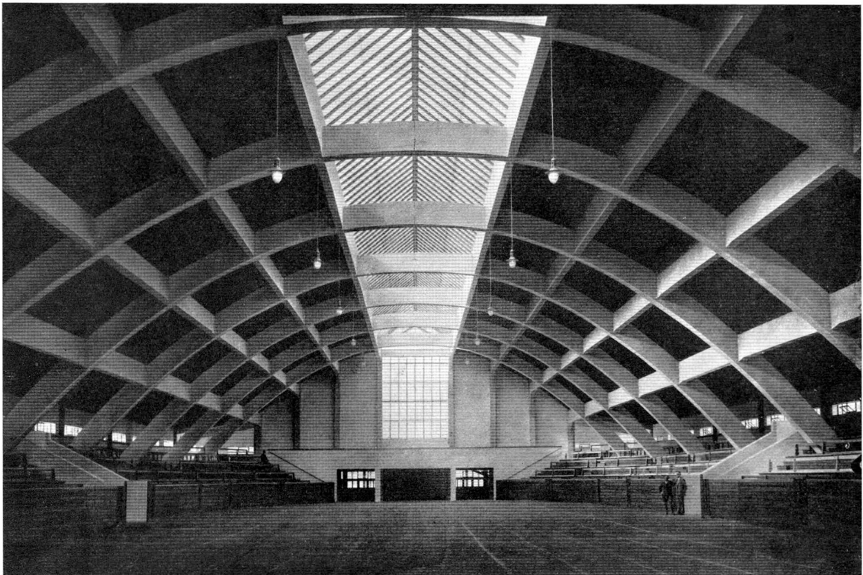
Abb. 100. Bruno Taut, Berlin: Ausstellungshalle „Stadt und Land“, Magdeburg. (Allgemeine Bau- & Eisenbeton G. m. b. H., Berlin) Lichte Scheitelhöhe: 11 m, Spannweite der Bogen: 34 m, Länge der Halle: 90 m
