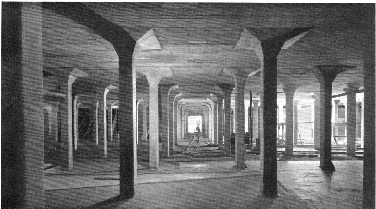
Abb. 120. Hochbehälter der Wasserversorgung Stuttgart. (Ludwig Bauer, Stuttgart). Höhe 3,75 m, Länge 60 m, Breite 55 m, Fassungsraum 10 000 m 3 . Pfeilerabstand 3,50 m
