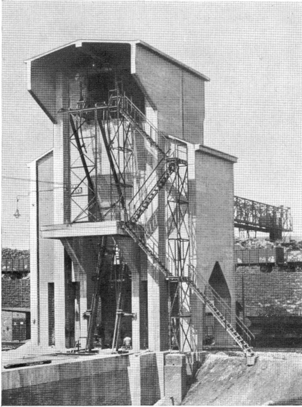
Abb.210. Agglomerieranlage der Rheinischen Stahlwerke Meiderich (Dyckerhoff & Widmann)
