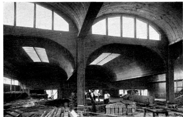
Abb. 7. Ing. Dischinger: Die Dywidag-Halle auf der Gesolei in Düsseldorf. (Dyckerhoff & Widmann), Innenansicht
