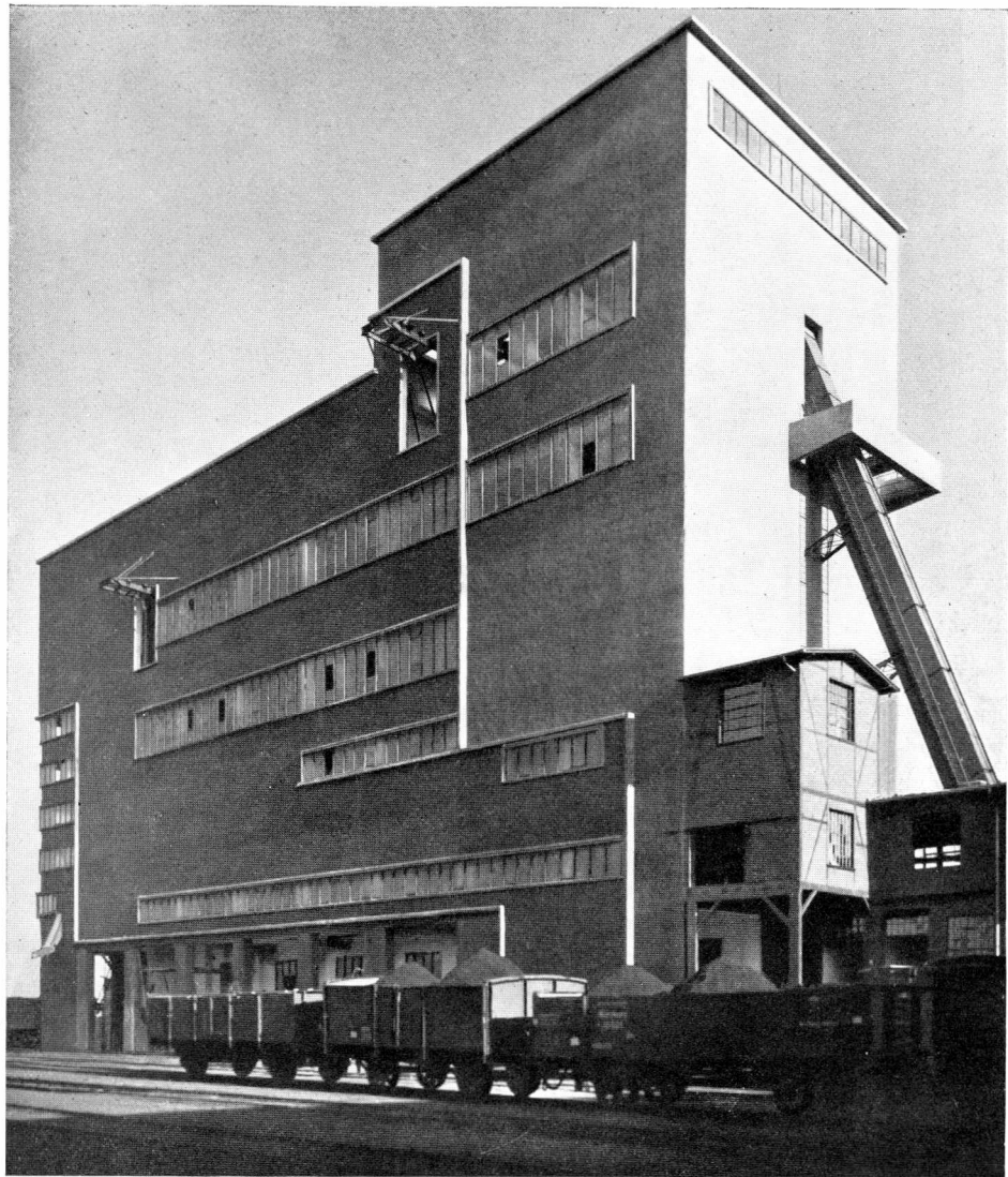
Abb. 174. Alfred Fischer, Essen: Kohlenwäsche Zeche Königsborn, Unna. (Wiemer & Trachte, Dortmund) Hinter den Fensterbändern die tragenden Stützen sichtbar; die dekorative Fassadenaufteilung erscheint entbehrlich
