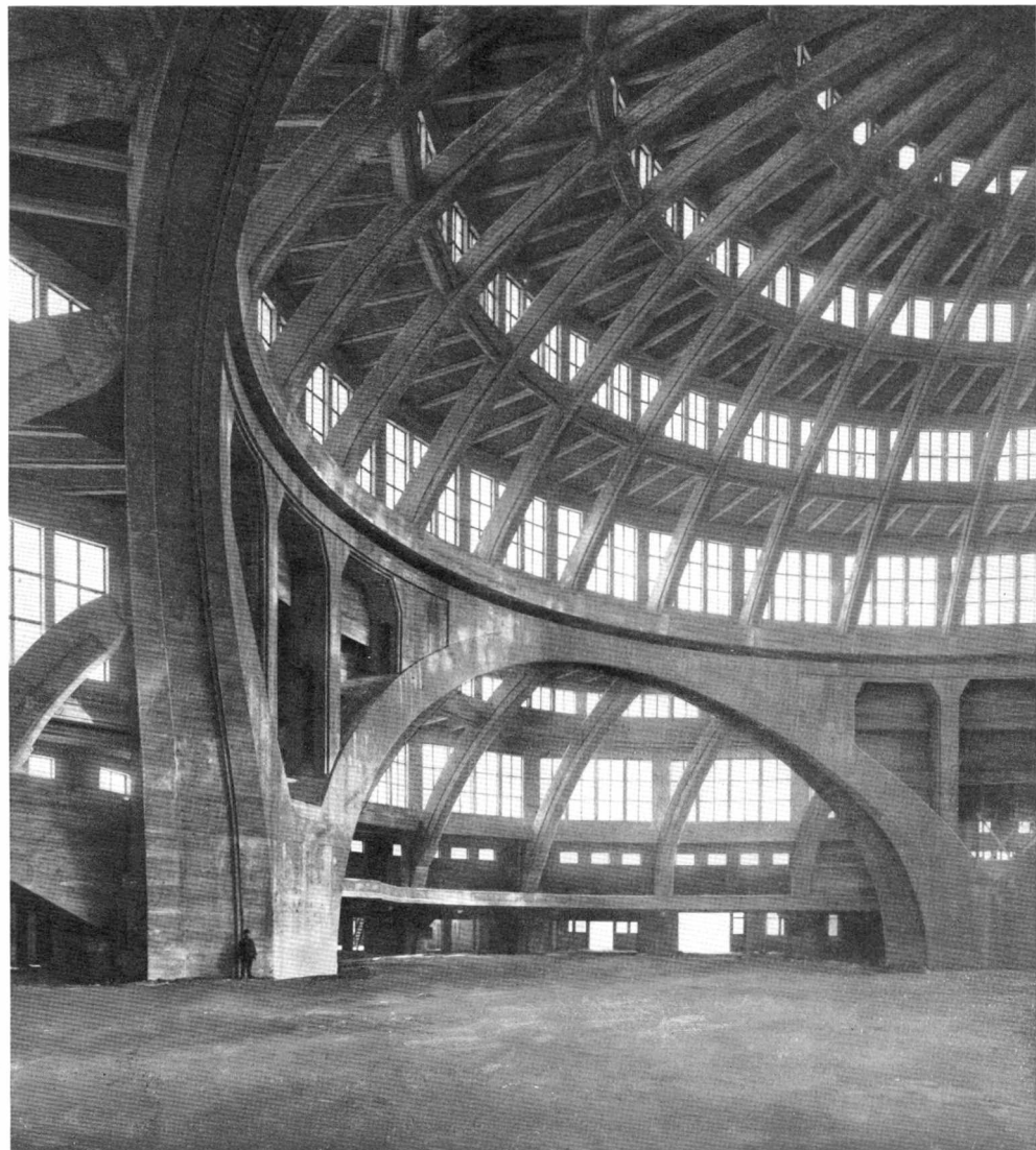
Abb. 86. Max Berg: Jahrhunderthalle Breslau (Dyckerhoff & Widmann) Grundfläche 5300 m, Durchmesser 65 m, Höhe 42 m
