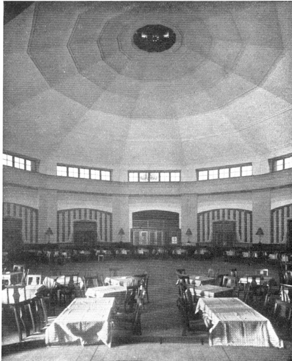
Abb. 110. Hanns Hopp: Messe-Hauptrestaurant Königsberg i. Pr. (Windschildt & Langelott). Rippenkuppel, Spannweite 26 m, Stich 4,60 m. Vgl. Seite 48/49
