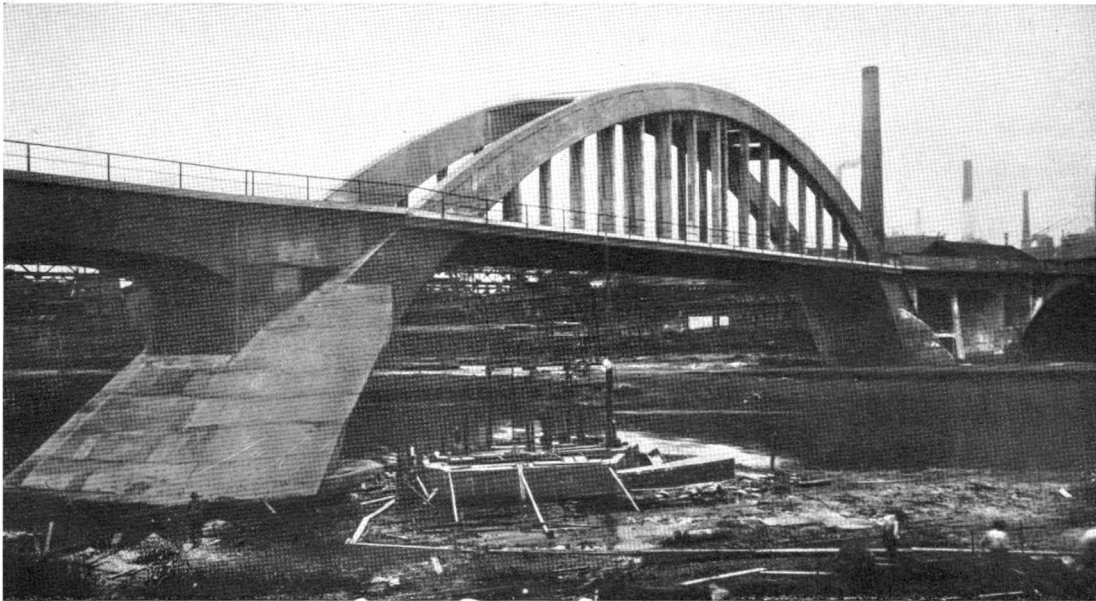
Abb. 244. Eisenbahnbrücke über die Saar in Völklingen (Wayß & Freytag) Spannweite 60 m, Fahrbahn 7,3 m über dem Wasser. Vgl. Abb. 207
