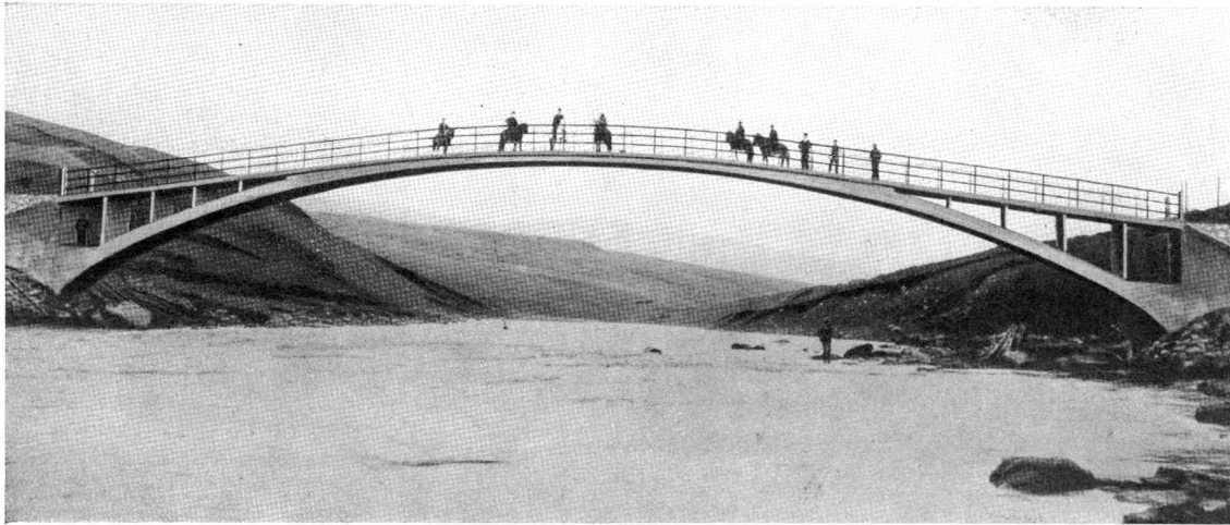
Abb. 238. Skogarbrücke in Island (Christiani & Nielsen Hamburg) Spannweite 54 m Fahrbahn 9 m über dem Wasser
