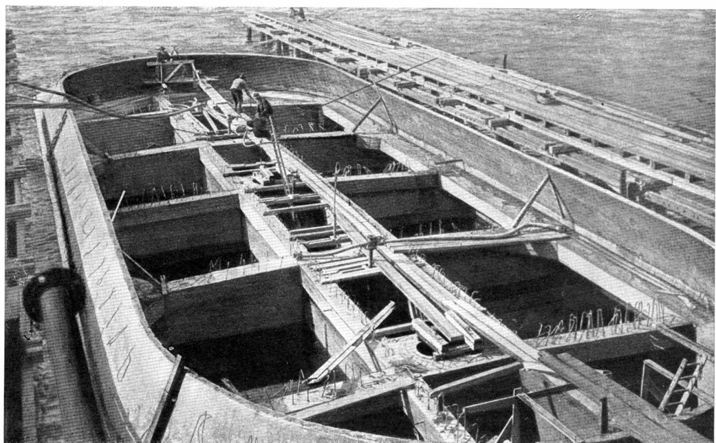
Abb. 134. Schwimmcaisson für eine Elbbrücke im Hamburger Freihafen (Dyckerhoff & Widmann) Länge 32 m Breite 12,8 m
