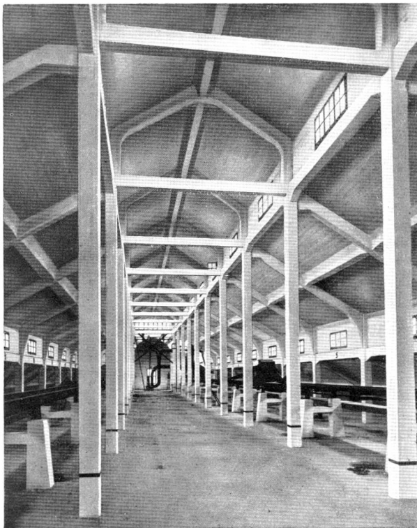
Abb. 65. Dachgeschoß im Hafenspeicher Landau (Dyckerhoff & Widmann)
