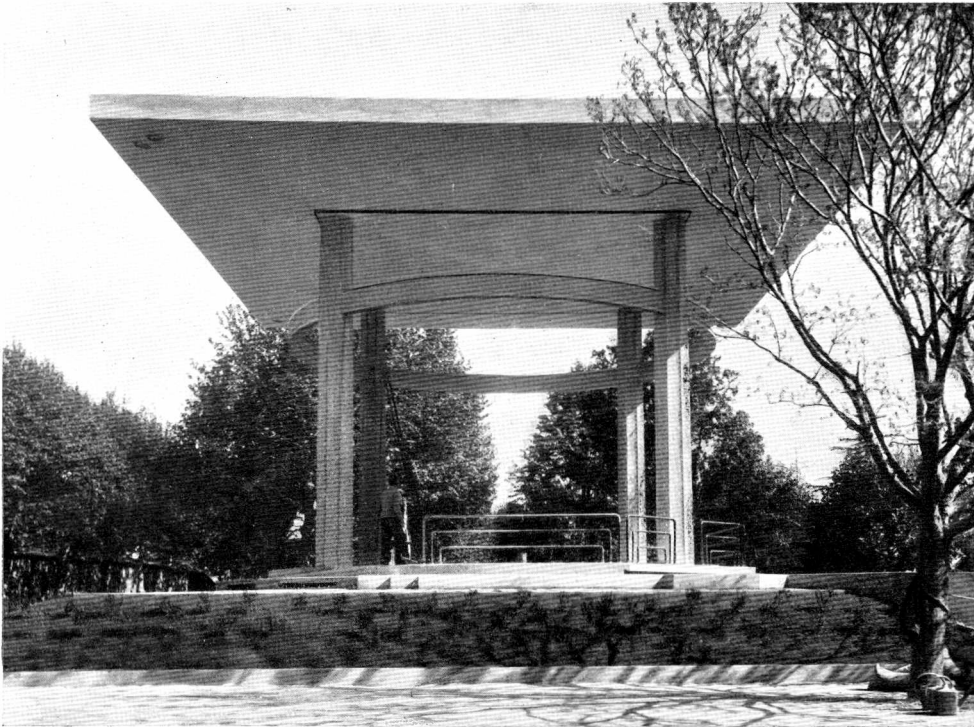
Abb.135. Marcel Bernard: Konzertpavillon in Montpellier. Im Unterbau Foyer, Garderoben, Maschinenraum usw. Säulen: 7 m hoch. Platte: 14 m im Geviert, Gewicht: 200000 kg. Beleuchtung im Ring unter der Decke
