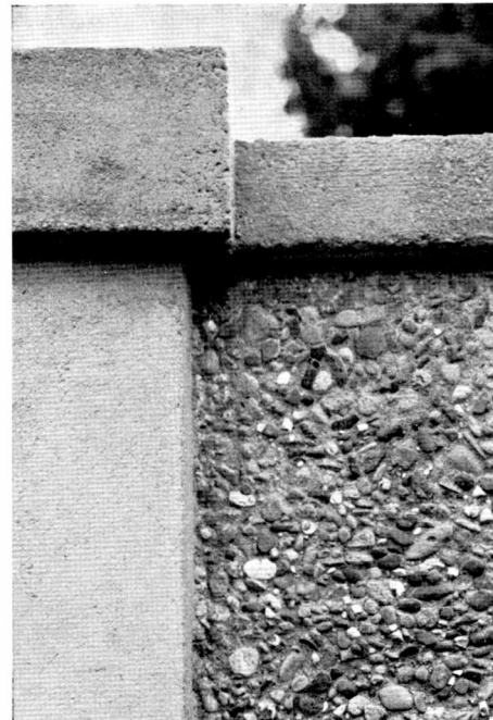
Abb. 147. Oberflächenbehandlung: Nach dem Contex-Verfahren bearbeitete Betonmauer
