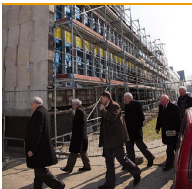
Po drodze z ul. Hoene-Wrońskiego, gdzie powstanie Strefa Kultury Studenckiej i wielopoziomowy parking, obserwujemy, jak demontowana jest stara konstrukcja elewacji wraz z oknami na bud. C-7 i wymieniana na nową, która zapewni dobrą termoizolację. W Polsce taki zabieg na użytkowanym budynku wykonano tylko do wysokości 5. kondygnacji. Na obiekcie należącym do Wydziału BLiW dokona się to na całości. Słychać głosy, że pracującym wewnątrz jest już nawet za ciepło!
