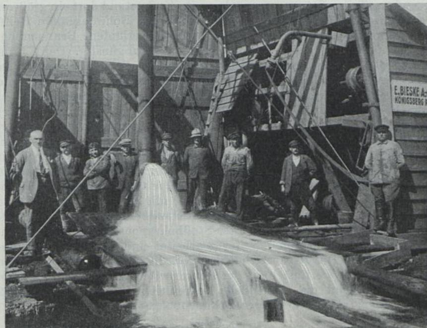
Abb. 169. Artesischer Überlauf am Rohrbrunnen IV des Wasserwerks Memel.
