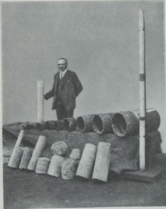
Abb. 19. Bohrkronen und Bohrkerne einer größeren Brunnenbohrung.
