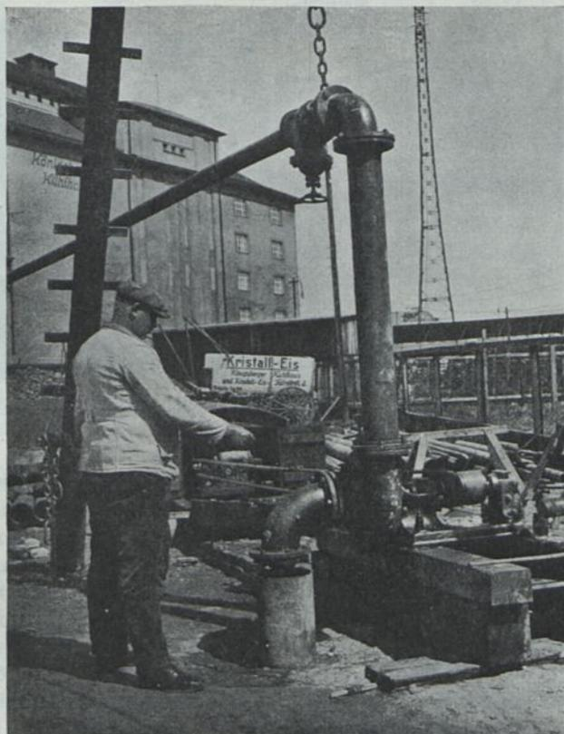
Abb. 138. Pumpversuch an einem Rohrbrunnen mit Kreiselpumpe. (Königsberger Kühlhaus und Kristalleisfabrik A.-G.)
