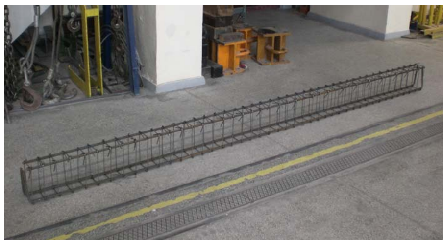
Fot. 4.7 – Gotowy szkielet zbrojenia (belka serii I)
