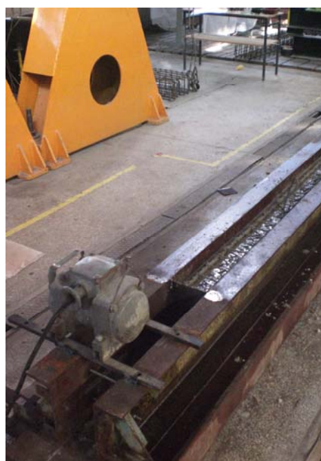
Fot. 4.12 – Zagęszczanie mieszanki betonowej
