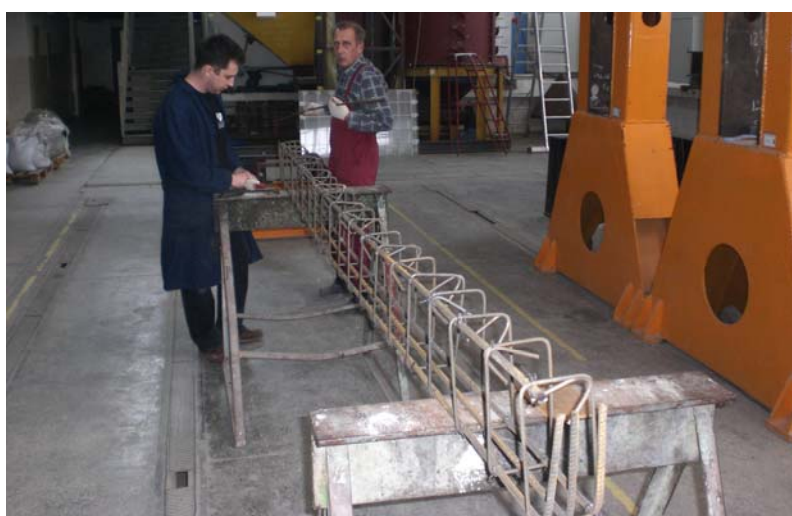
Fot. 4.10 – Wykonywanie szkieletu zbrojarskiego belki serii III
