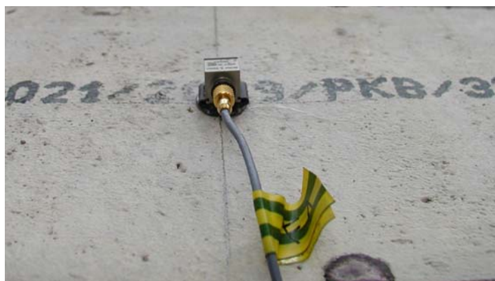
Fot. 4.3 – Akcelerometr przymocowany do belki
