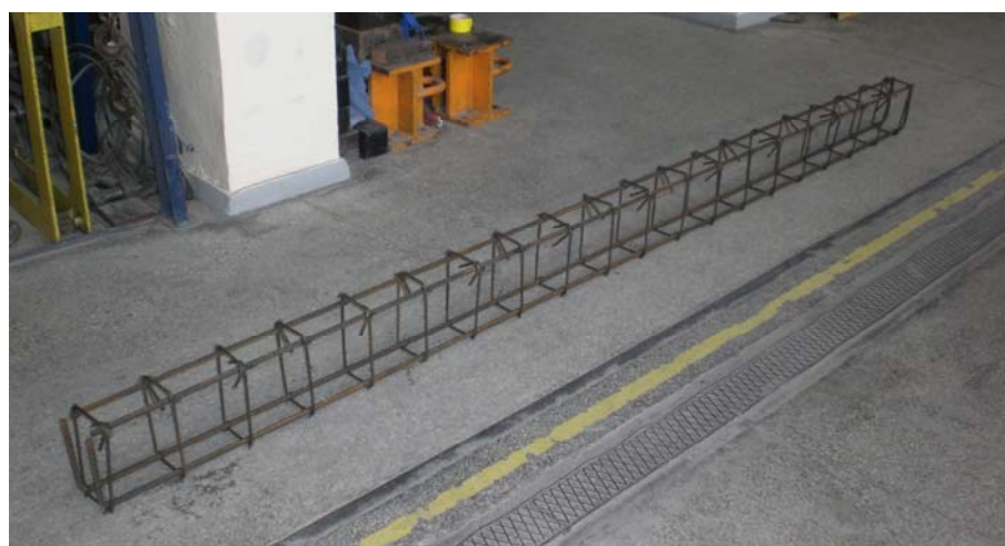
Fot. 4.8 – Gotowy szkielet zbrojenia (belka serii II)
