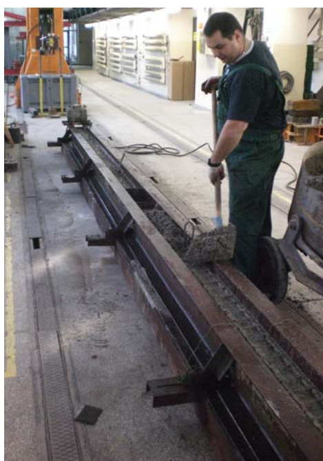
Fot. 4.11 – Układanie mieszanki betonowej
