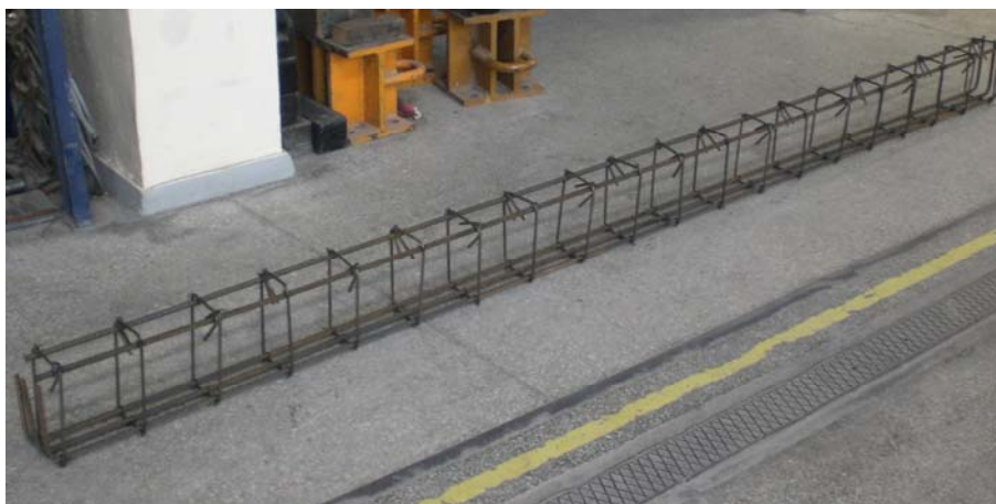
Fot. 4.9 – Gotowy szkielet zbrojenia (belka serii III)
