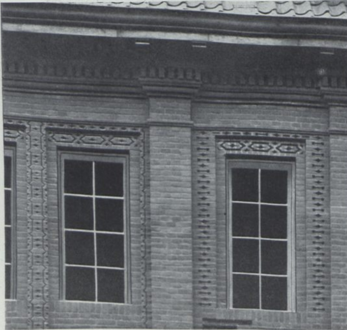
Abb. 19. TEILANSICHT DER ZIEGELBEARBEITUNG
