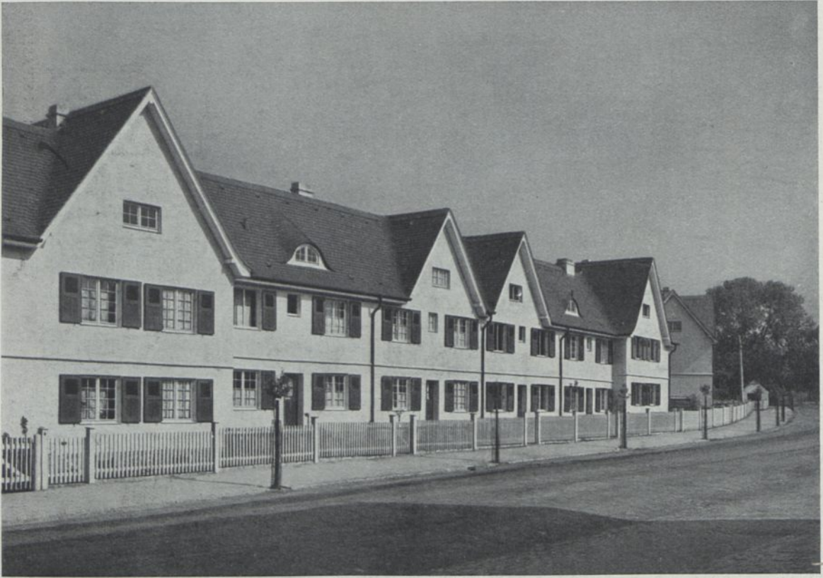
Abb. 269. HAUSER AN DER DRESDENER STRASSE
