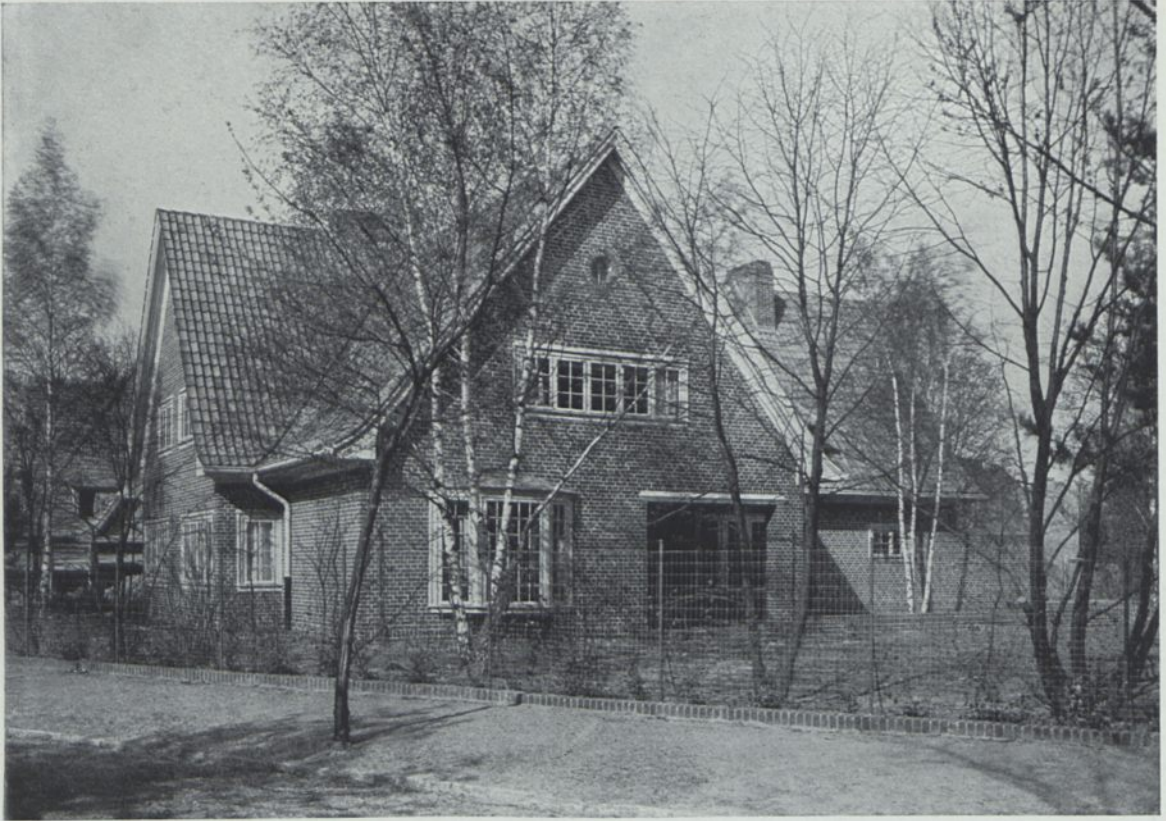
Abb. 48. ANSICHT VON DER STRASSE
