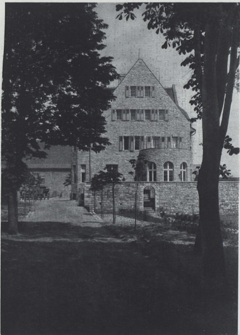
Abb. 40. ANSICHT VON SÜDOSTEN
