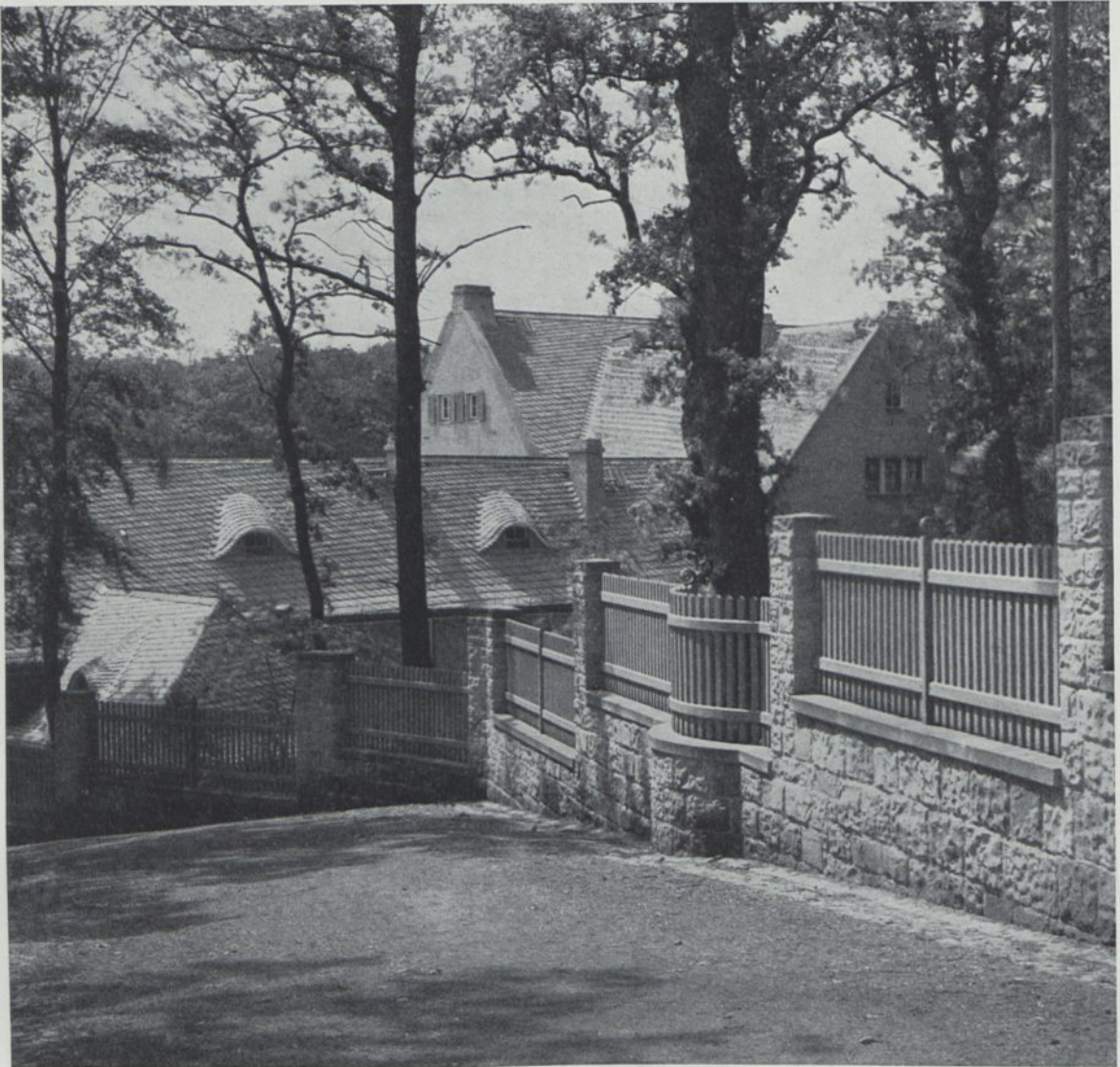
Abb. 117. AUFSICHT AUF DIE BAUGRUPPE VON DER OBEREN WALDSTRASSE
