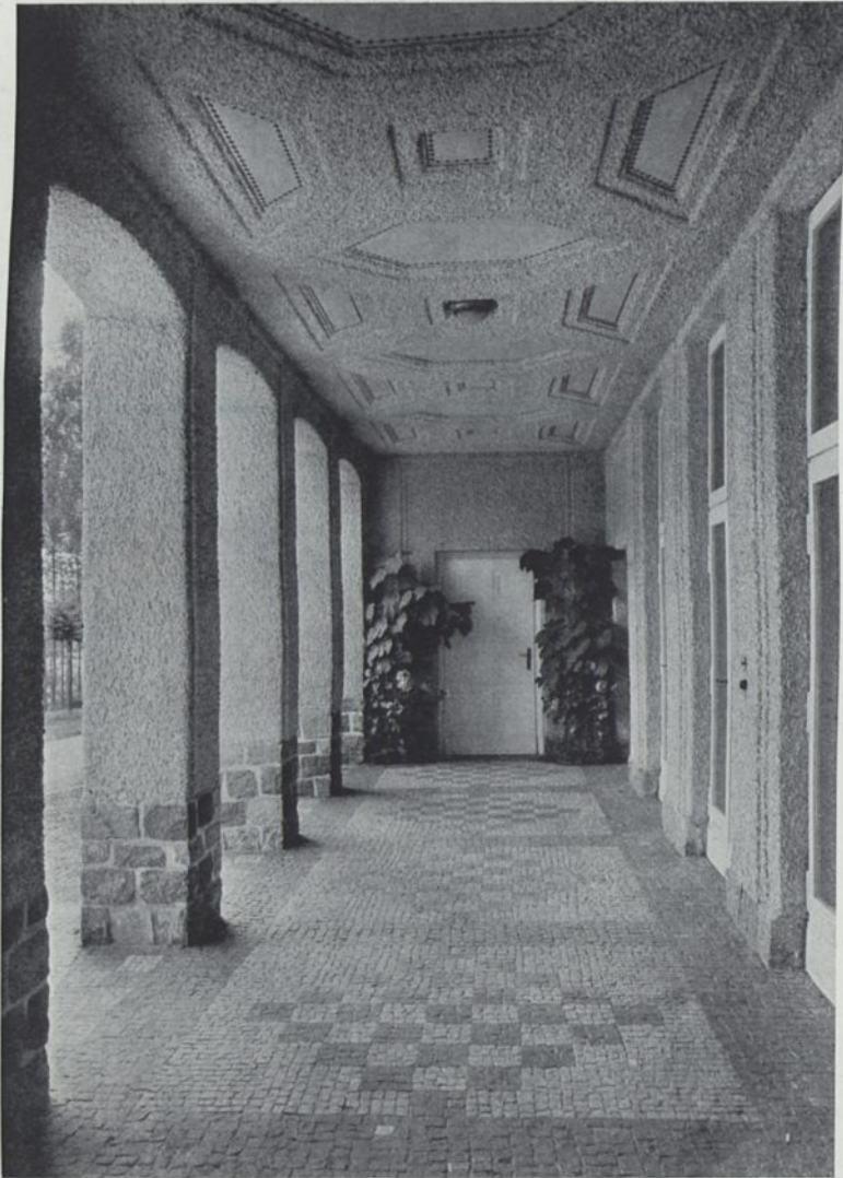
Abb. 74. OFFENE VORHALLE AN DER SEESEITE
