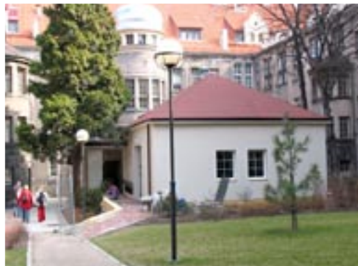
Budynek laboratorium przed, w trakcie i po remoncie.
