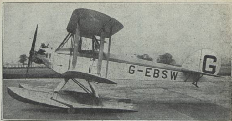
Blackburn „Bluebird II“ b (1927) Üw 2; E: F. A. Bumpus b = 8,53 m; M: Siddeley 60 PS-HP-CV; Bst.: H, St, S.
