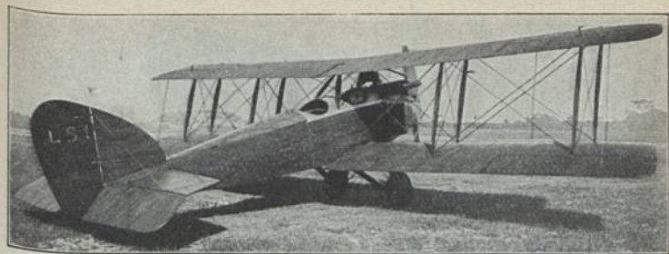
Fuetterer Schoettler I (1924) Ü 2; E: E. O. Fuetterer, F. L. Schoettler b = 12,04 m; l = 8,35 m; T = 37,30 m 2 ; L = 0,74 t; N = 0,42 t; G = 1,16 t; V = 72-197 km/h; M: Mercedes 160 PS-HP-CV; Bst.: H. St.
