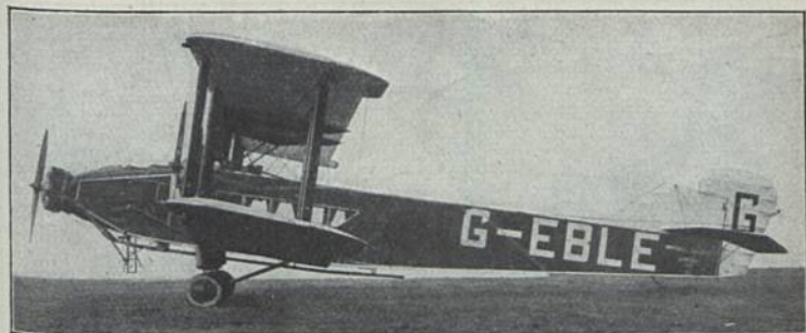
Handley Page W 9 „Hampstead“ (1925) V 16; E: F. Handley Page b = 24,17 m; l = 18,19 m; T = 145,4 m 2 ; L = 4,15 t; N = 2,61 t; G = 5,76 t; V = 88—184 km/h; H = 4,1 km; St = 0,24 km/1'; M: 3 × Siddeley 385 PS-HP-CV = 1155 PS-HP-CV; Bst.: H, St, S.
