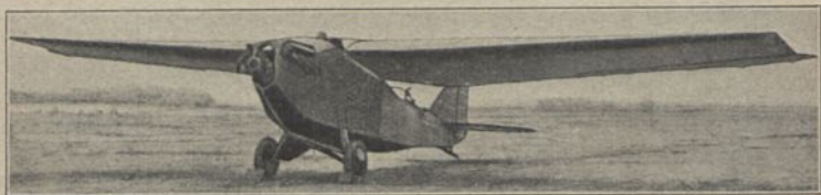
Barron (1923) Ka 2; E: R. Barron M: Hispano 300 PS; MG: 3; Bst.: Dural
