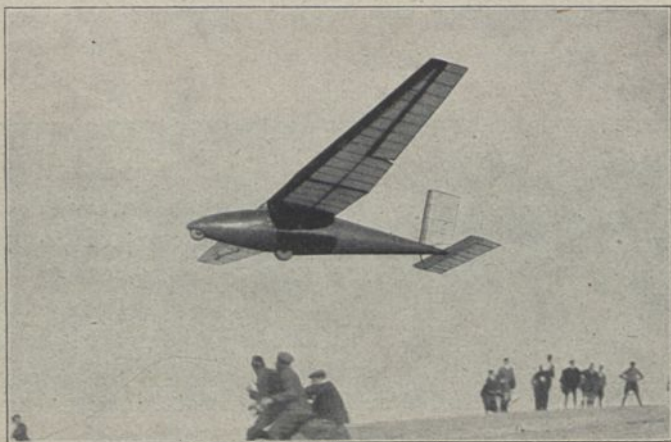
Hannover H 6 „Pelikan“ (1924); E: Mertens, Koch, Meyer-Cassel b = 15,00 m; T = 15,00 qm; l = 5,26 m; Bst.: Holz, Stoff
