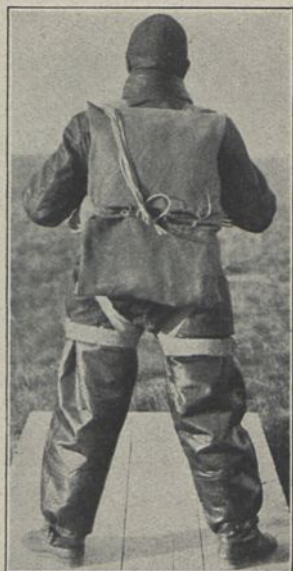
Unz-Rückenpolster (1918) Keinerlei Seilverbindung zwischen Schirm und Luftfahrzeug. Öffnen geschieht durch Hilfsfallschirm. Schirmhülle in Briefum- schlagform.
