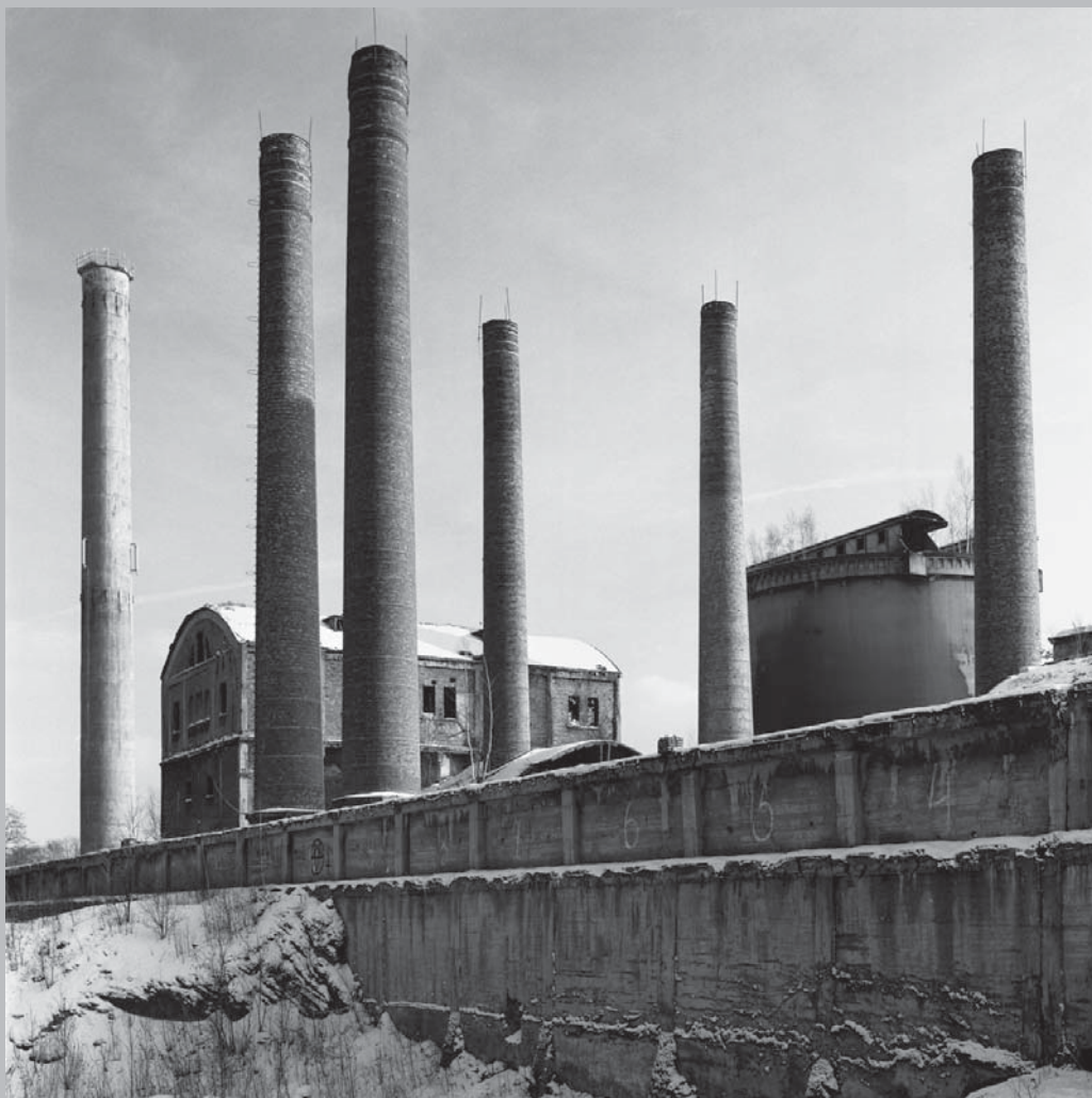
„Grodziec” cement mill, Grodziec, 20.11.2005
