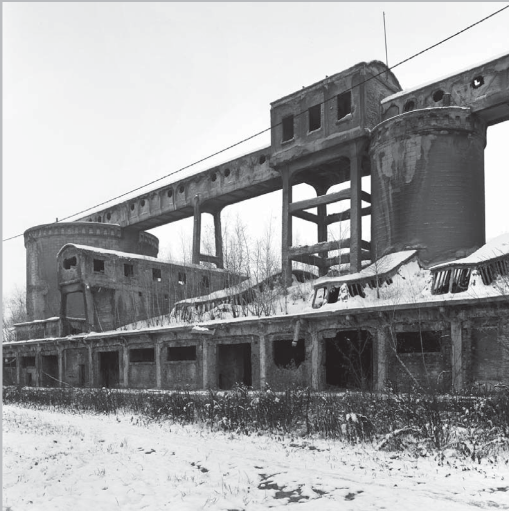
„Grodziec” cement mill, Grodziec, 26.01.2005
