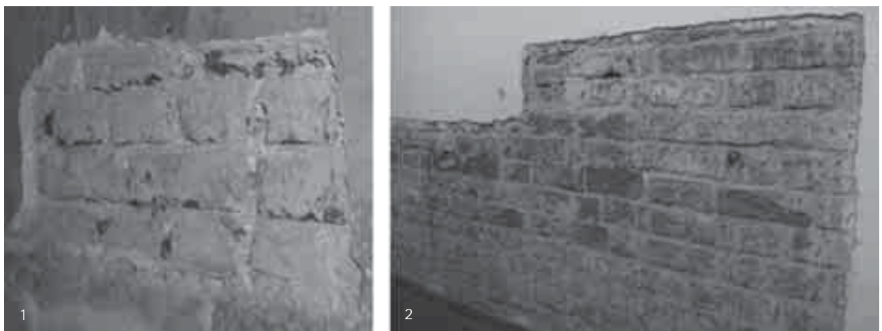
Il. 8. Kościół, ściany z widocznym budulcem: 1 – północne ramię transeptu, 2 – empory chórowa, 2007 r. Fig. 8. The church, walls with visible building material: 1 – north transept arm, 2 – choir gallery, in 2007
