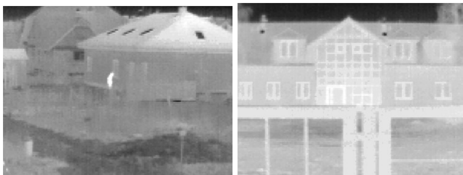
Rysunek 14.10: Termowizyjny obraz współczesnego domu mieszkalnego (po lewej) i współczesnego budynku użyteczności publicznej
